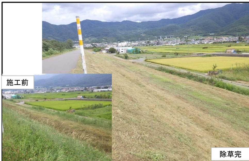
堤防の除草作業が主となります。除草は堤防法面に植生する草を刈りはらうことで、堤防表面の変状把握管理用道路上からの視界の確保通行の確保、並びに草からの病害虫等飛散による耕作物、果樹への影響をなくす為に行います。
