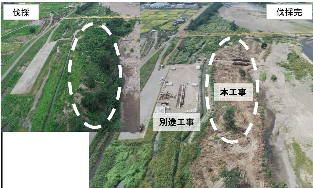
本工事は、国土強靭化工事の一環として、洪水の流下の支障となる河道内樹林を間伐し樹木の繁茂による流下能力の低下、砂洲の固定化に伴う河岸近接物の偏流箇所の改善を図る工事です。
