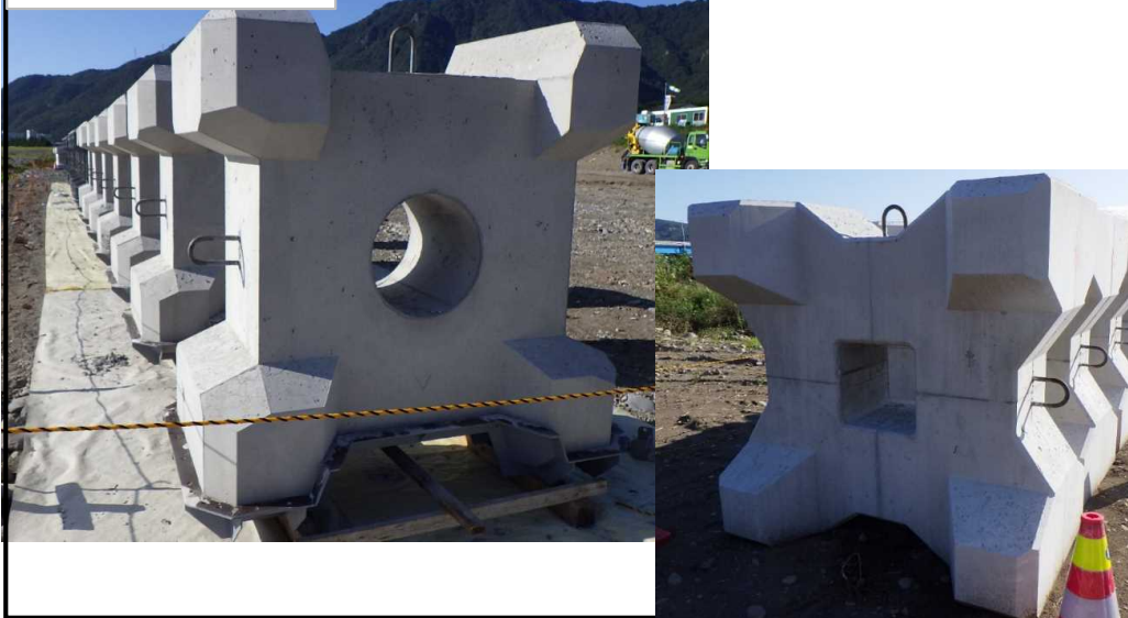
根固めブロック製作
