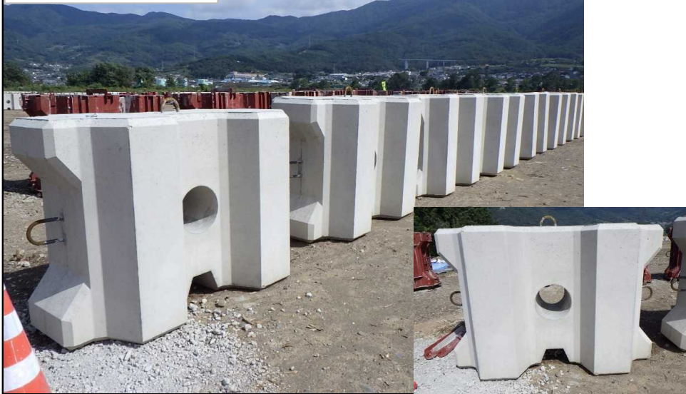
根固めブロック製作
