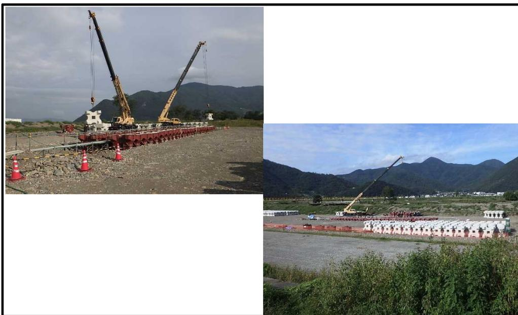
当工事は、令和元年10月の台風19号により被災した箇所(坂城町鼠宿地先 距離標97.5k+316m～98.0k+24m)の護岸復旧工事です。
