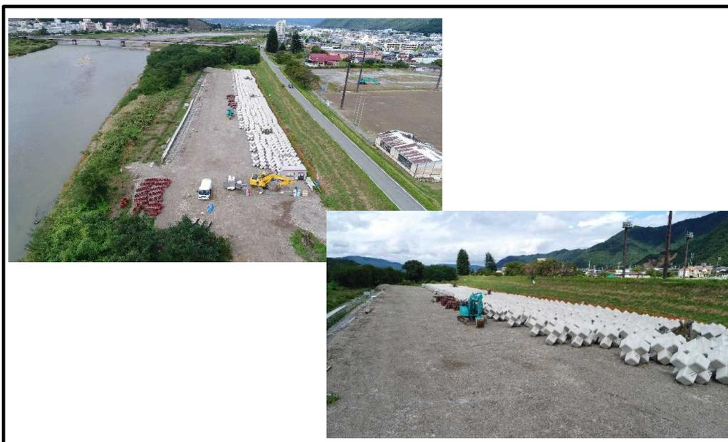
本工事は、昨年の台風19号により被災した箇所、坂城町南条（距離標96.0k+40m～96.0k+380m）の護岸復旧工事です。復旧延長L=340mの内L=200mの護岸復旧を行います。
