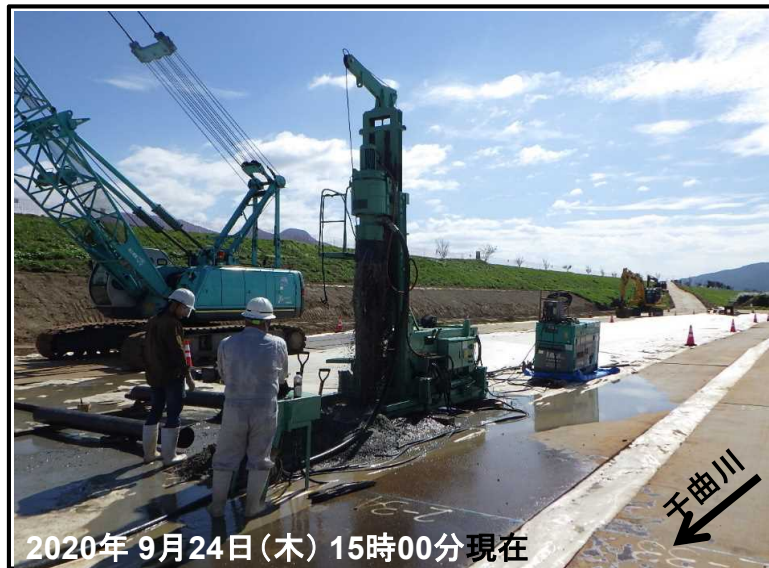
さく井工削孔状況
