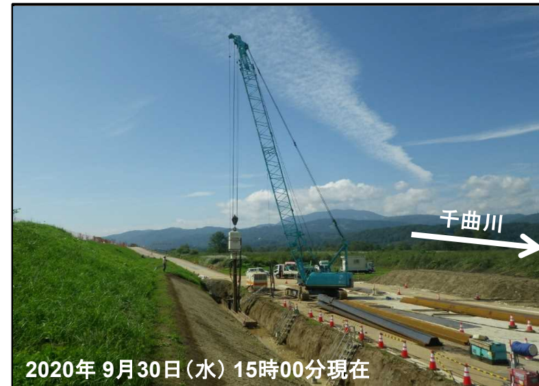
鋼矢板(ハット型L=15.0m)打設状況
