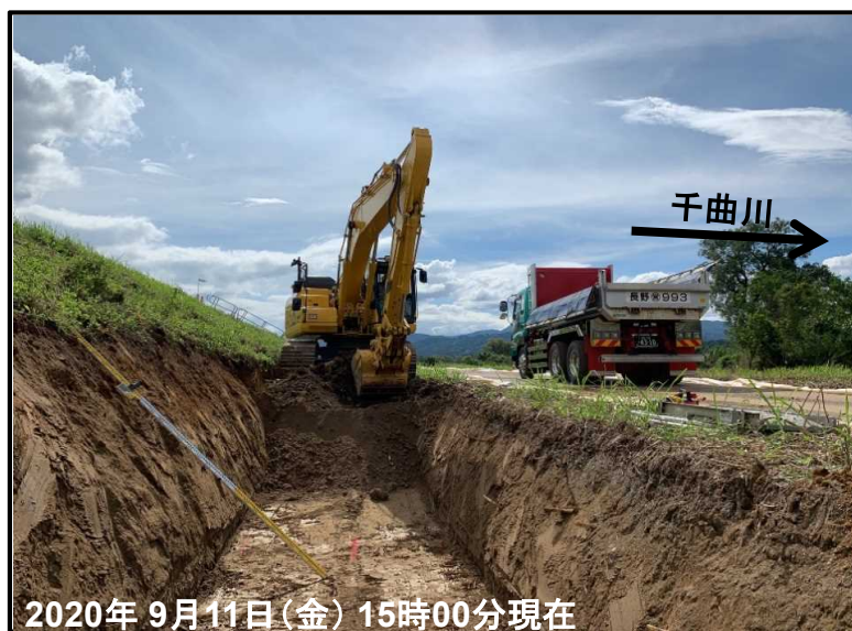
鋼矢板打設箇所掘削状況
