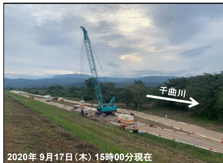
鋼矢板(ハット型)打設状況
