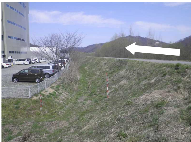
七貴工区着手前
