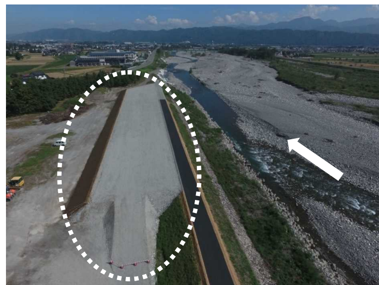
9月末現場状況 造成盛土工・舗装工完了 L74.00k付近
