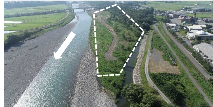
光地区下流部 8月末現場状況
