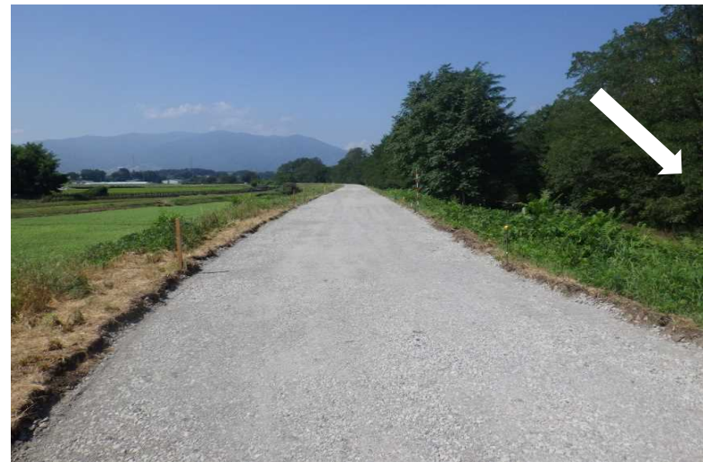
新村地先 8月末現場状況
