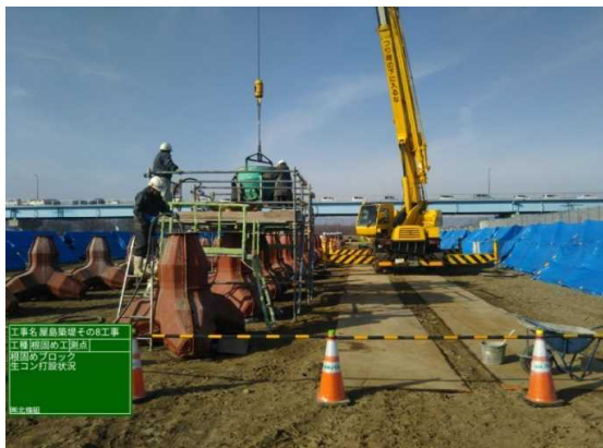
根固めブロック作成状況(落合橋)
