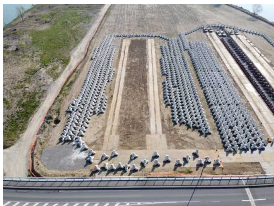
根固めブロック製作完了 509個
