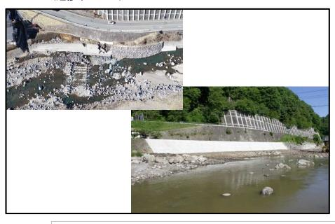
東馬流工区は、崩落した護岸ブロック積の復旧工事を行い、 現場作業は5月末にて完成となりました。
