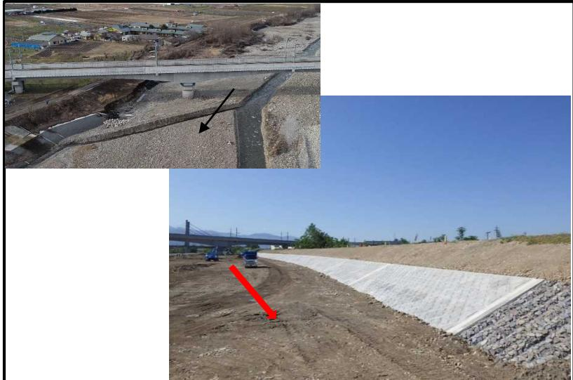
5月末までに大型ブロック張護岸・根固工が完了しました。6月下旬頃には全体工事完了予定です。早期の完了を目指しています。
