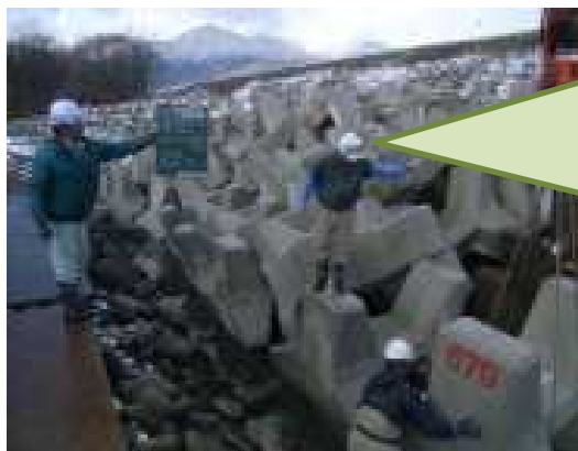
合図者の明示 クレーンオペレータに見やすく
