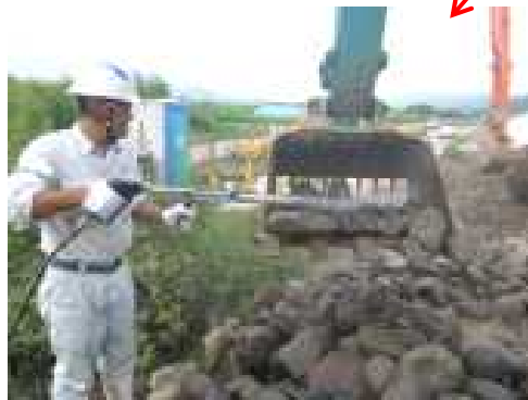
スケルトンバケット+ハイウォッシャーで付着物を除去
