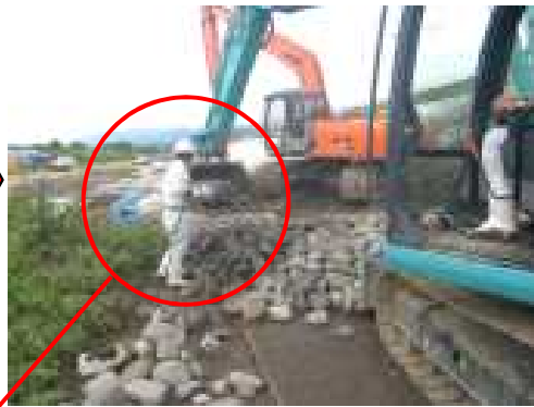
スケルトンバケット+ハイウォッシャーで付着物を除去
