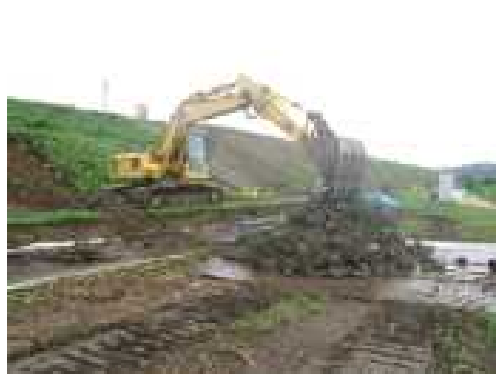
既設かご石撤去
