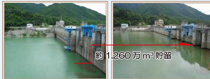
平成18年7月洪水時に大町ダムにおいて特例的に50 m 3 /sのみの放流を25時間続け、洪水をカットしている状況
