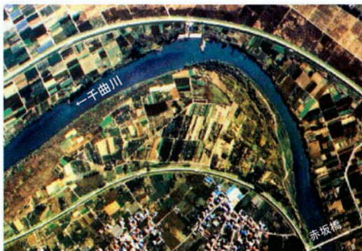
施工前（平成元年10月） 荒地草地の高水敷が発達し、河積が不足していました。
