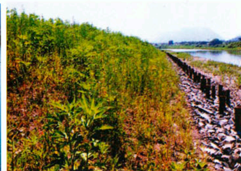
施工後4ヶ月 植物が侵入し自然な景観になりました。
