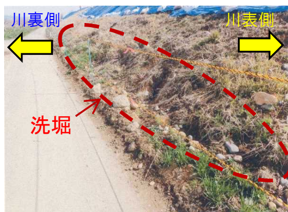
左岸57.0km付近②
