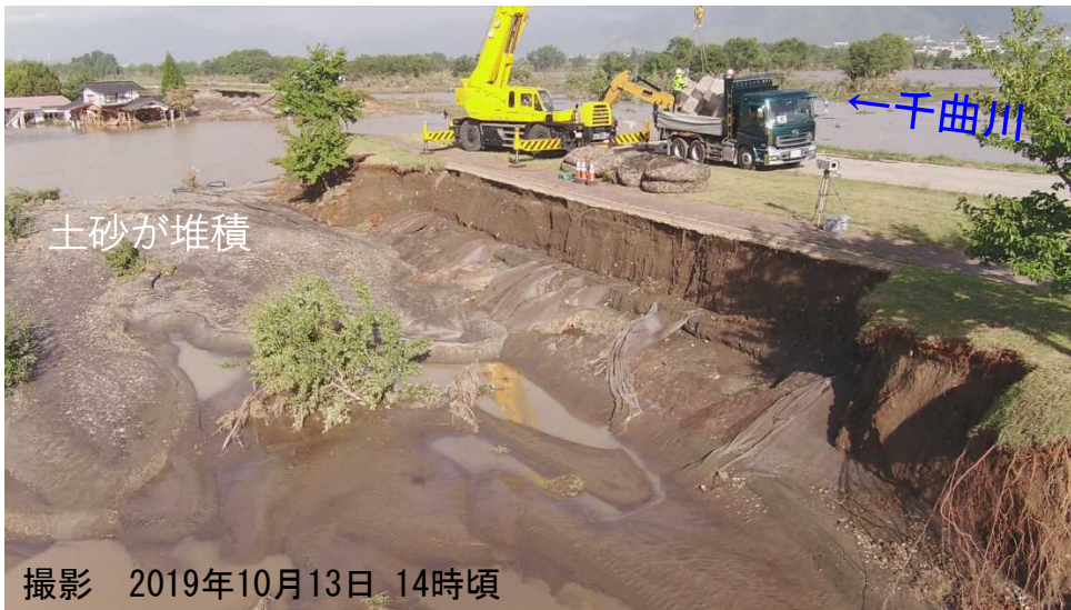
越水により川裏側堤体（主に桜づつみ）が侵食を受けた決壊地点上流の状況
