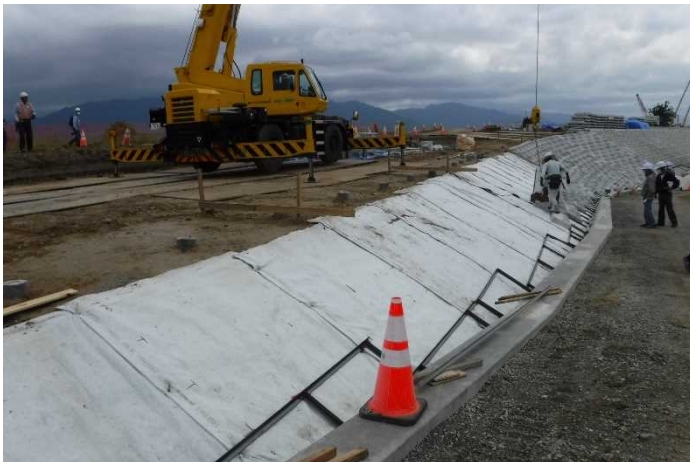
工事の状況(復旧工事箇所)
