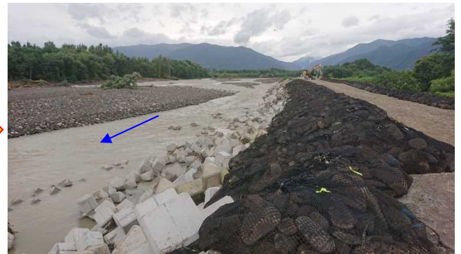
応急復旧作業完了後(8月19日時点)
