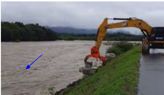
被災箇所 応急復旧工事中 (R3.8.15撮影)
