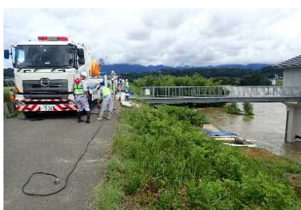
中野市 本沢川樋門 (8月15日 13:00)
