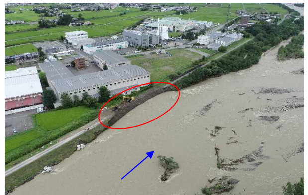
被災箇所 応急復旧工事中 (R3.8.16撮影)
