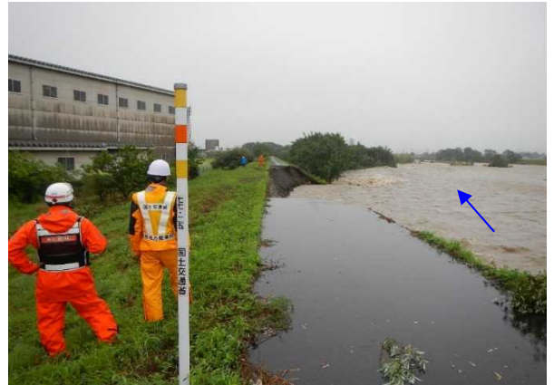
被災箇所 応急復旧着手前 (R3.8.15撮影)
