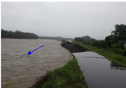
応急復旧作業前(8月15日時点)
