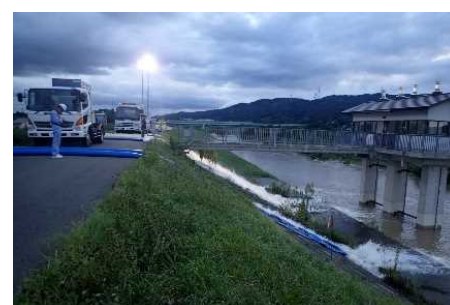
中野市 清水川樋門 (8月15日 18:20)
