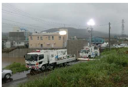
長野市 浅川排水機場 (8月14日 17:10)
