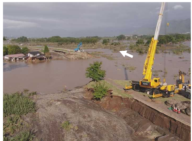
決壊箇所(堤防天端) (R1. 10. 13 撮影)
