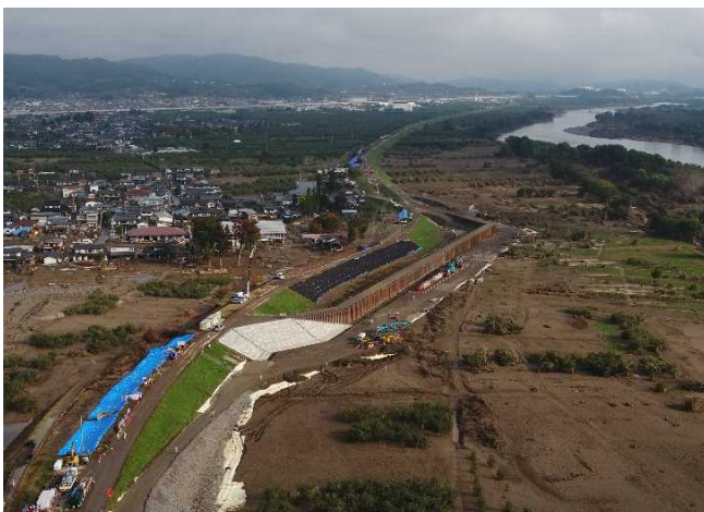
鋼矢板仮締切堤防 完成 (R1. 10. 30 撮影)
