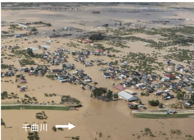
決壊箇所(住宅地側)上空より (R1. 10. 13 撮影)
