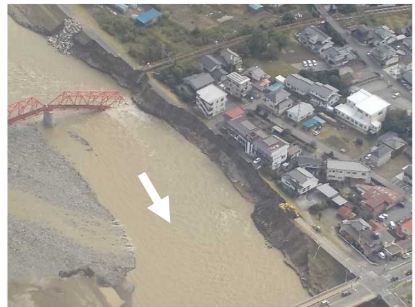
欠損箇所 上空より (R1. 10. 15 撮影)
