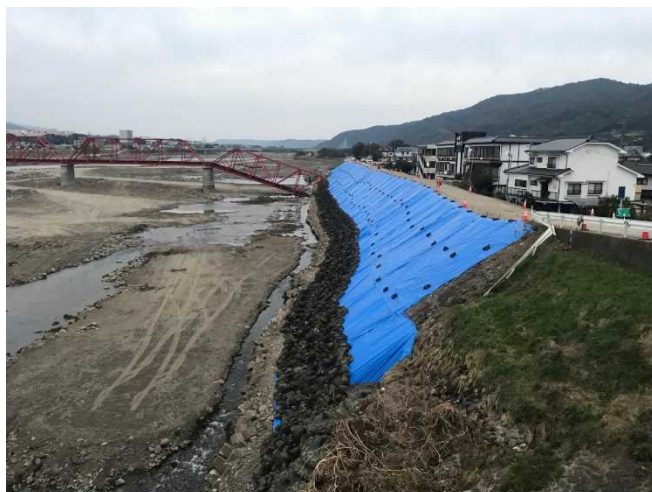
緊急復旧工事 完成 (R1. 11. 03 撮影)
