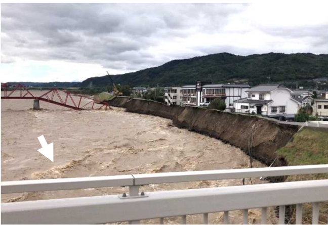
欠損箇所 上田橋より (R1. 10. 13 撮影)
