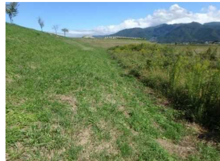
H30.10.1 11:40 堤内地状況
