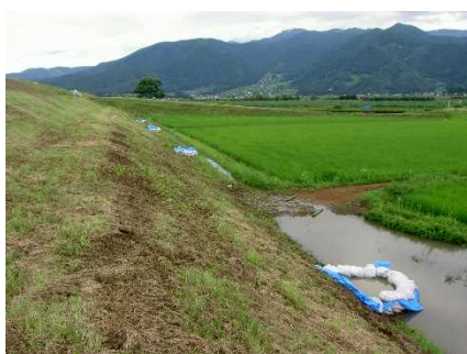
(H18.7)漏水発生、月輪を実施
