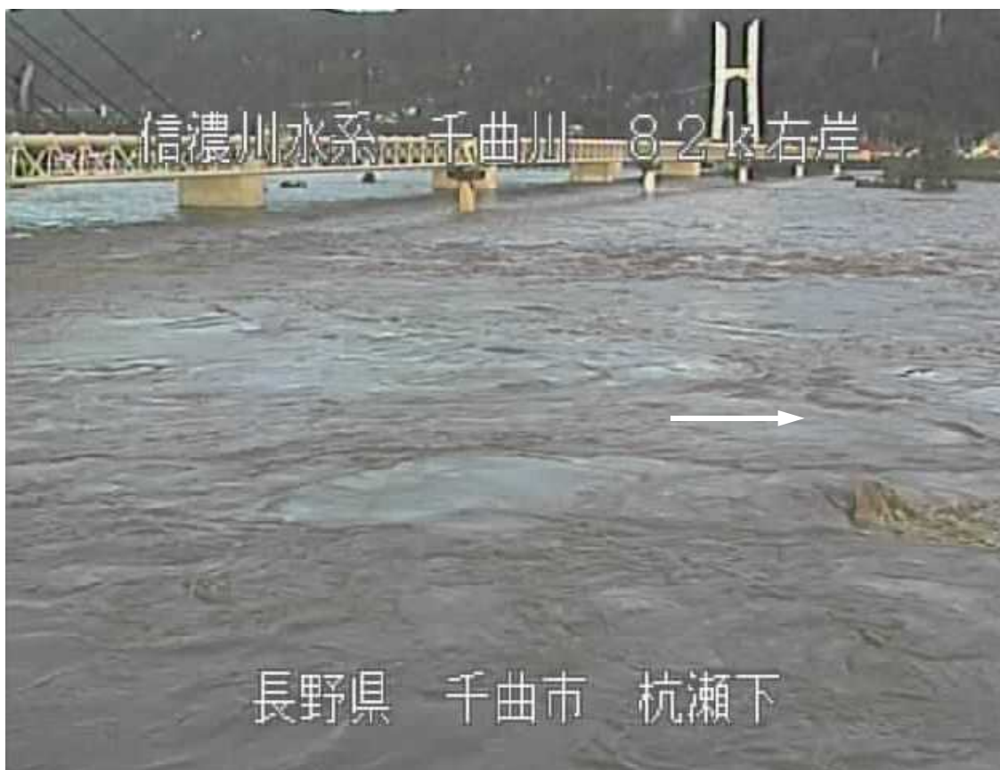
杭瀬下観測所 右岸より上流を撮影 10月1日 6時10分
