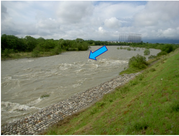
護岸の侵食や河道状況を確認
