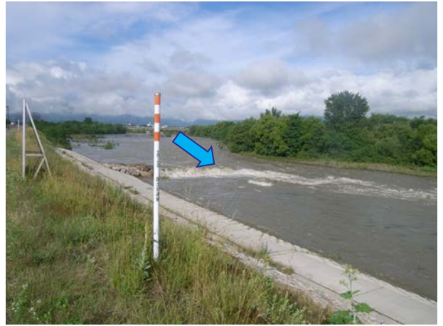
護岸侵食状況を確認
