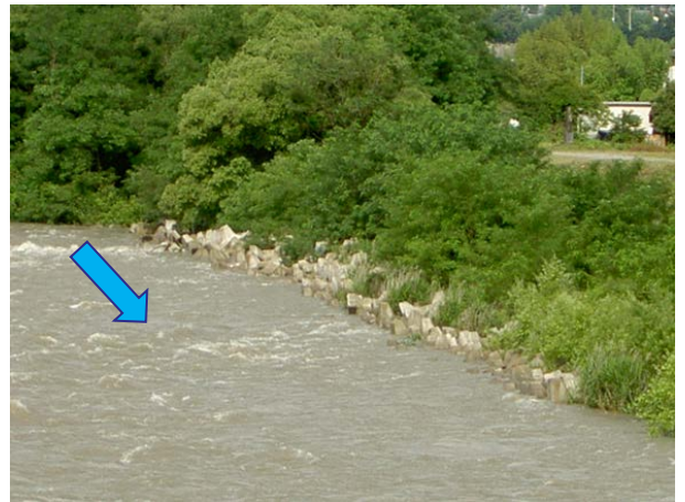
根固工の流出状況確認
