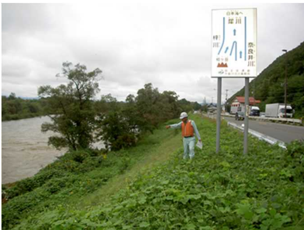
河岸浸食状況を確認
