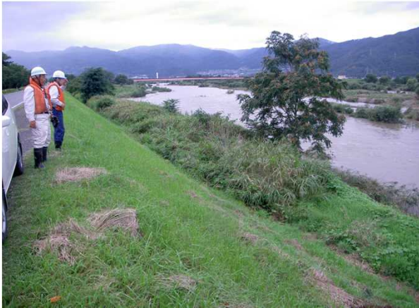
護岸の浸食や対岸状況を確認
