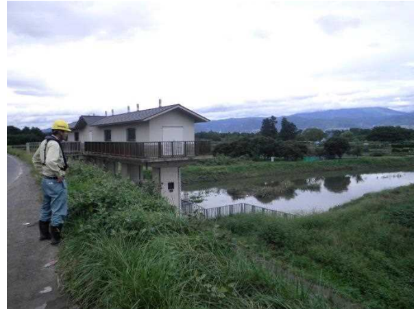
支川への逆流や樋門状況を確認
