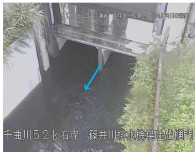
吐出樋門より排水状況
