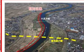
河道掘削（国）・小須戸橋架替（国・市）
