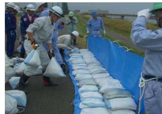
「改良積土のう工」
