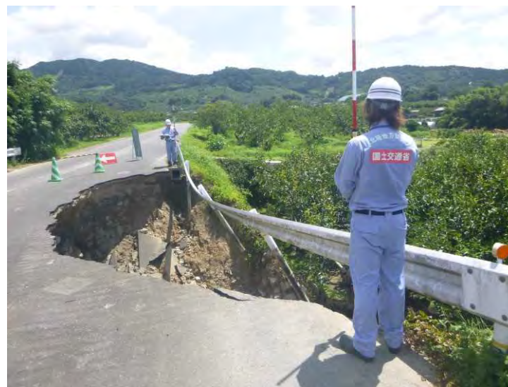
▲写真① 朝倉市道被災状況調査 被災状況調査班(道路)[長岡国道事務所]
