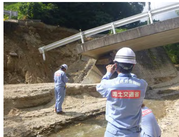
▲写真② 朝倉市道被災状況調査 被災状況調査班(道路)[長岡国道事務所]
