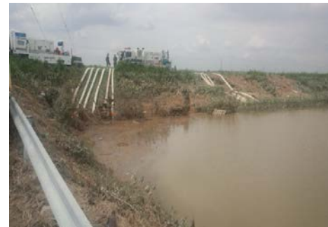
大橋橋詰での排水作業
