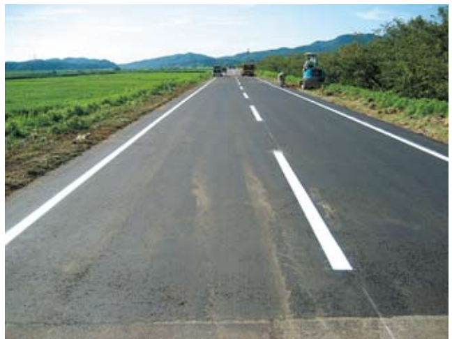
写真2-1-14 応急復旧完了
