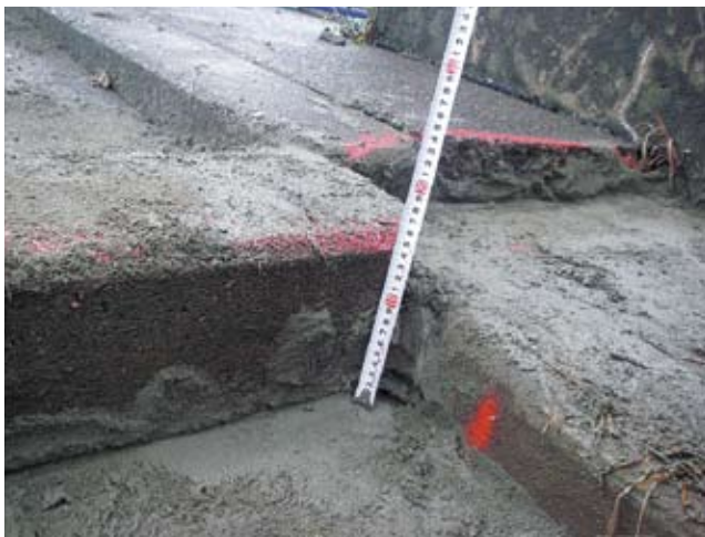
写真2-1-5 護岸沈下
