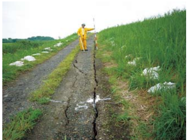
写真2-1-8 堤防亀裂
