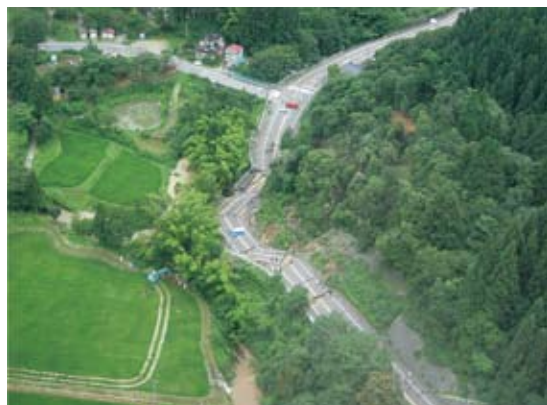
写真3-8-1 崩壊した国道8号
