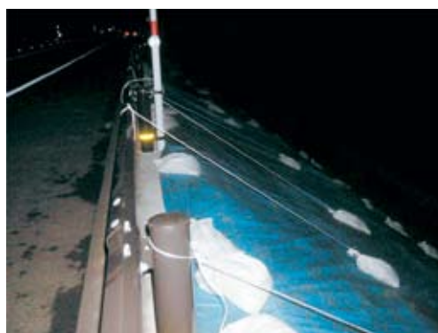
写真2-1-8 シート張り施工状況
