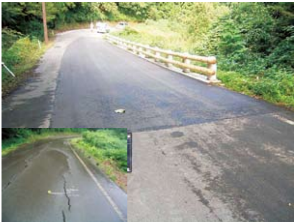
写真4-4-3 幹線園路（復旧9.10）
