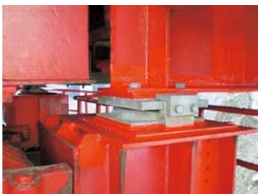
写真4-3-11 支承取替完了
