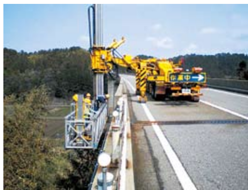
写真3-10-3 緊急橋梁点検(能登有料道路)
