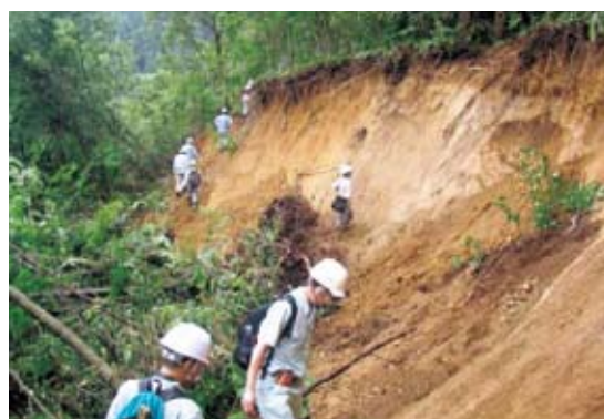
写真3-8-3 地すべり上部、滑落崖の確認
