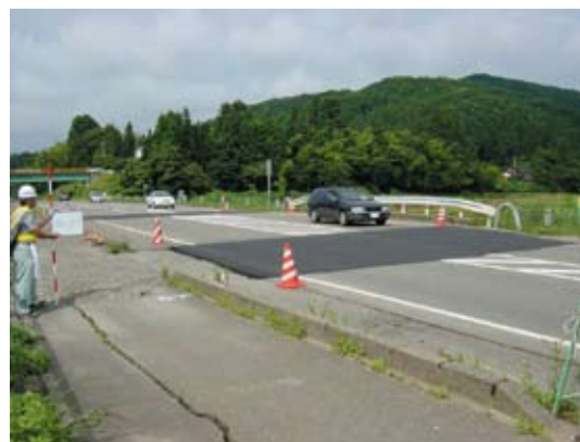
写真2-2-30 段差をすりつけ開放(藤掛川橋)
