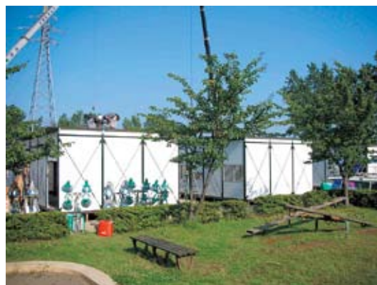
写真2-3-16 仮設住宅建設状況(柏崎市駅前公園)
