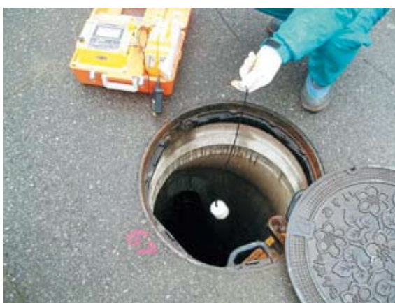
写真3-2-4 マンホール内酸素濃度測定(1次調査)
