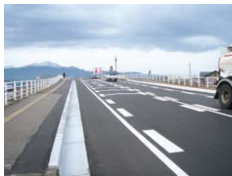
写真4-3-8 歩車道舗装完了
