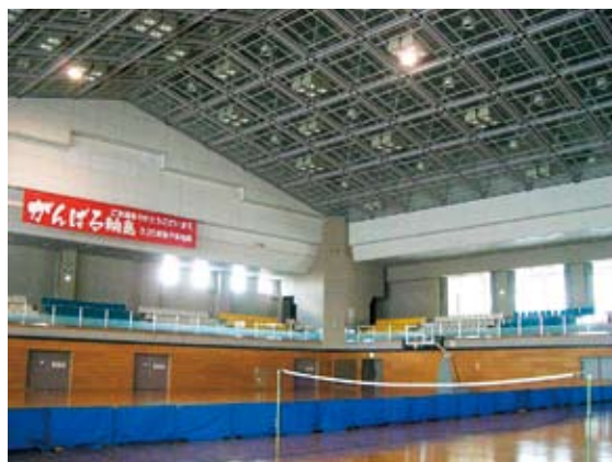
写真4-2-1 体育館の復旧状況
