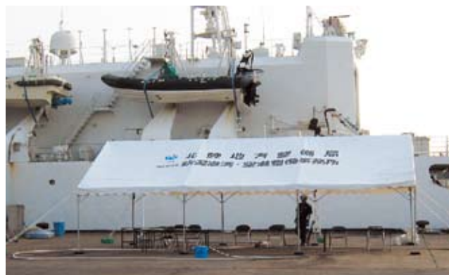
写真3-14-12 柏崎港給水管理用日よけテント設置状況その2(中浜埠頭3×5間)
