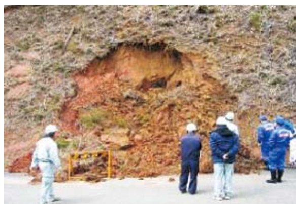
写真3-6-2 現地調査状況(穴水町鹿路)
