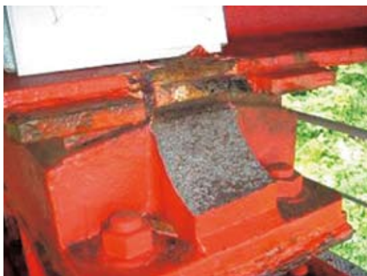
写真4-3-9 支承の破損
