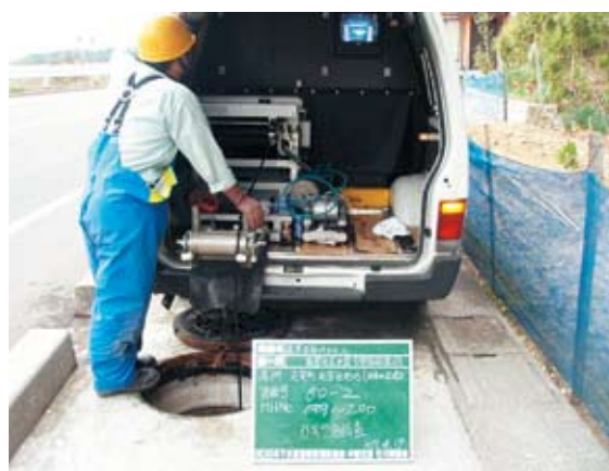
写真3-2-5 マンホール内のカメラ調査(2次調査)
