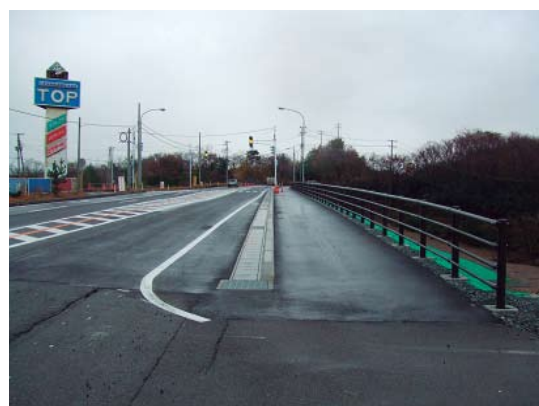
写真2-2-28 復旧完了(柏崎市鯨波)
