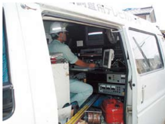
写真3-4-4 2次調査実施状況 （モニターで管路内の被害を確認）
