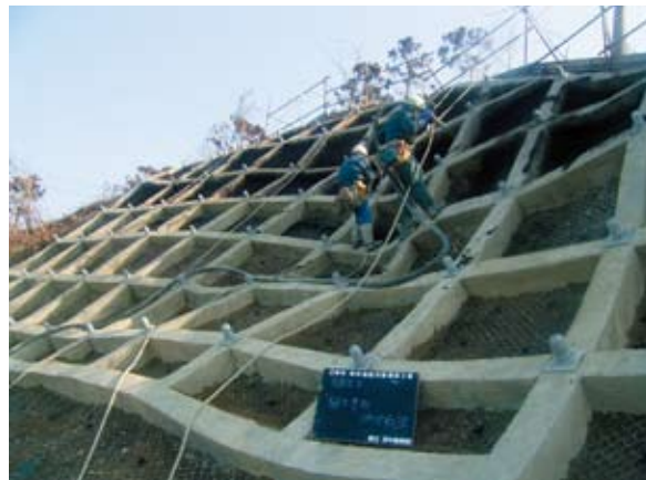
写真4-3-14 法面への植生基材吹き付け状況
