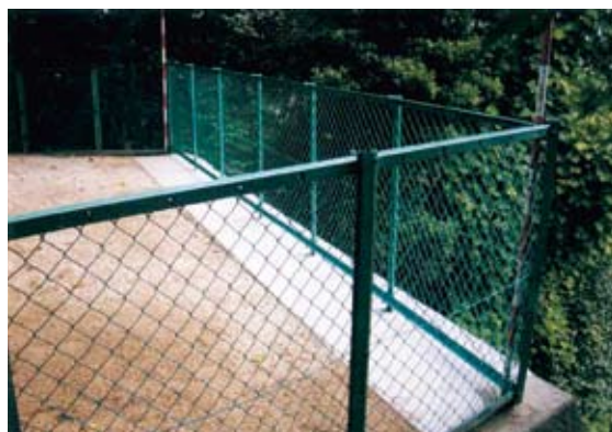
写真4-2-2 フェンスの復旧状況
