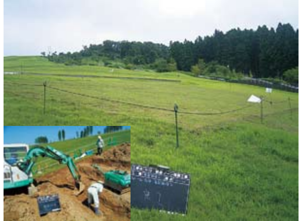
写真4-4-2 法面（補修完了9.4）
