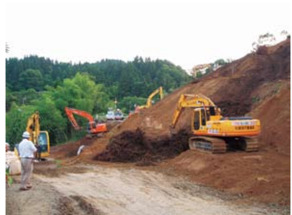
写真2-2-18 切土施工状況(長岡市大積千本町)
