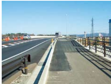
写真4-3-4 歩車道舗装打換完了
