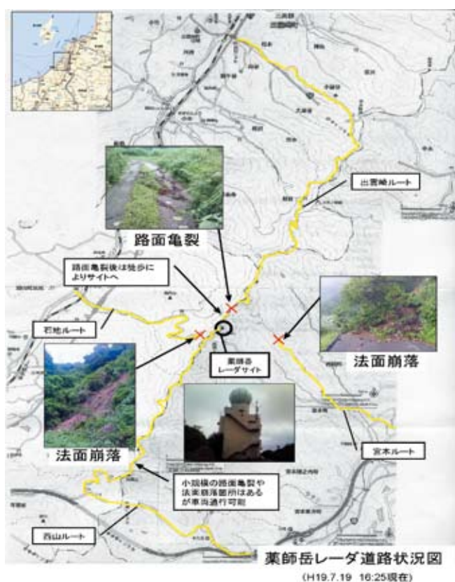
図2-5-1 薬師岳レーダ雨雪量計 道路状況
