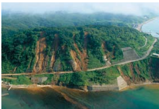
写真3-8-4 斜面崩壊した国道352号
