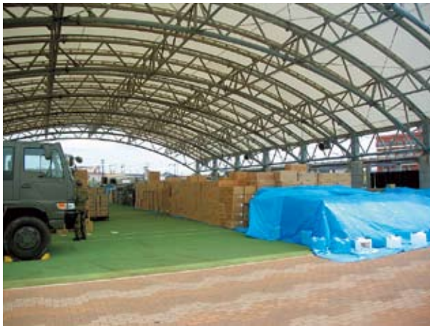
写真3-14-2 支援物資の保管状況(夕日ドーム)
