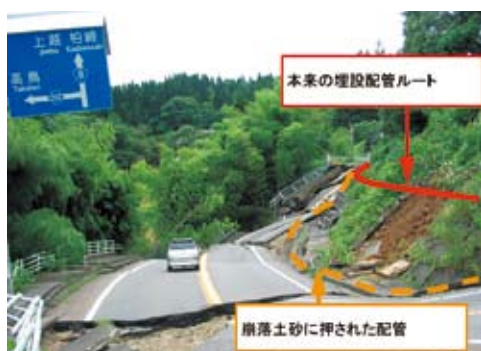
写真2-5-9 本来の配管ルートと被災後の位置
