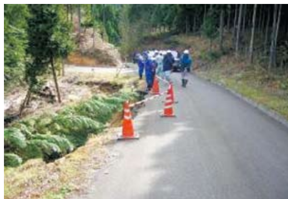
写真3-6-4 現地調査状況(穴水町上中)
