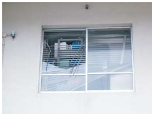
写真2-6-2 柏崎維持出張所窓ガラスの破損
