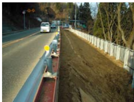
写真4-3-2 土留め矢板設置状況
