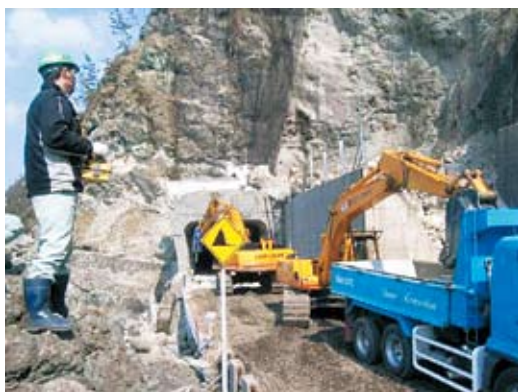
写真3-10-2 遠隔操縦式BH(八世乃洞門)
