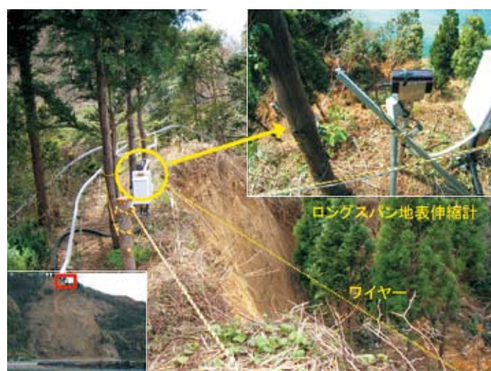
写真2-7 能登半島地震により発生した地すべり（輪島市門前町深見）
