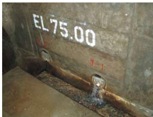
写真3-5-3 正善寺ダム調査状況及び漏水状況
