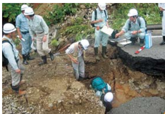
写真3-8-2 道路を寸断した亀裂箇所の調査
