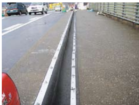
写真4-3-7 落下物防止用に設置したゴムシート
