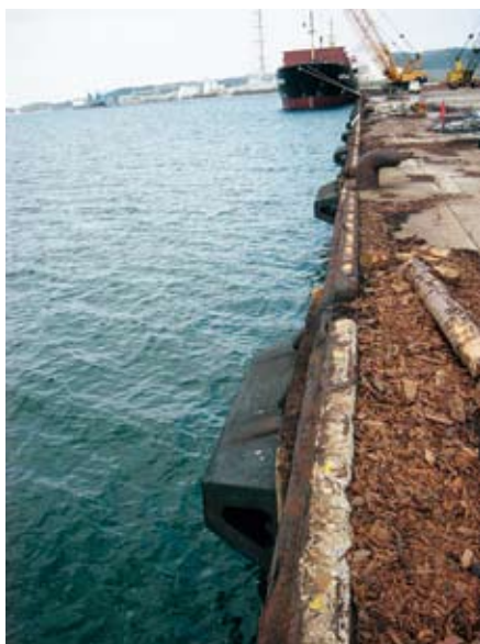
岸壁前面状況(H19. 3. 29技調撮影) 1号→2号
