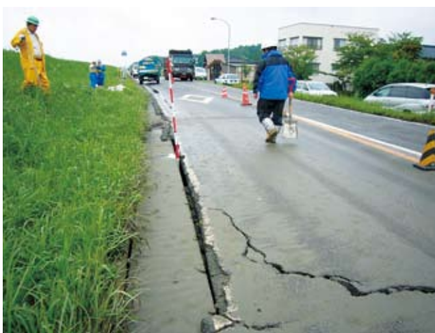
写真2-1-9 堤防亀裂
