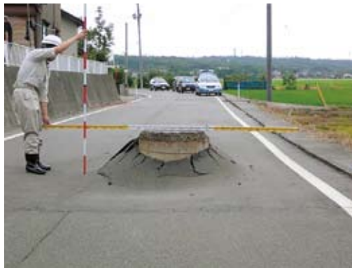
写真2-3-18 下水道管渠の被災状況(左: 柏崎市北園町、右: 柏崎市長崎新田)
