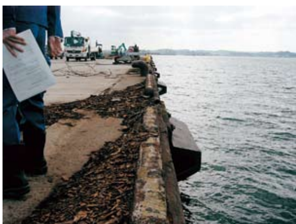
岸壁前面状況(H19. 3. 29技調撮影) 2号→1号
