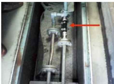
写真2-5-5 発動発電装置 給油管の可とう部を耐油性ホースで仮補修
