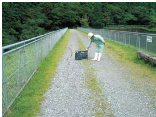
写真3-5-1 川内ダムの天端クラック状況
