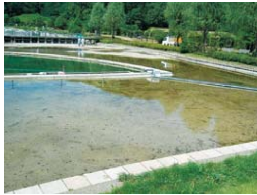
写真2-3-6 越の池(漏水発生)
