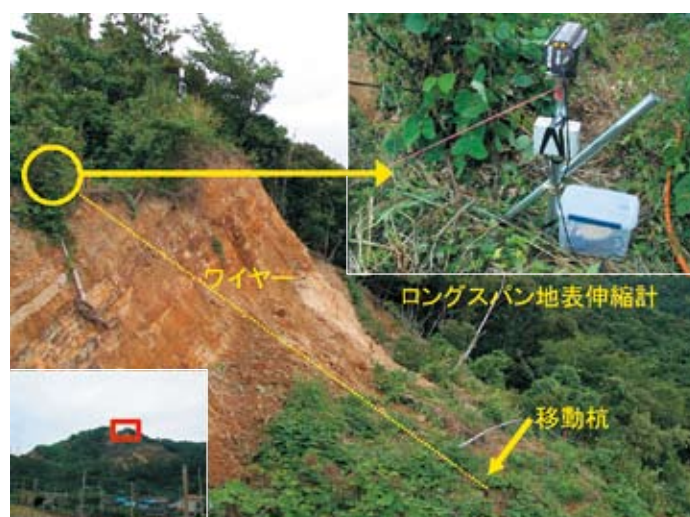
写真2-8 新潟県中越沖地震により発生した地すべり（柏崎市米山）
