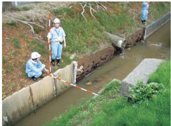
写真3-7-4 現地調査(柏崎市内)
