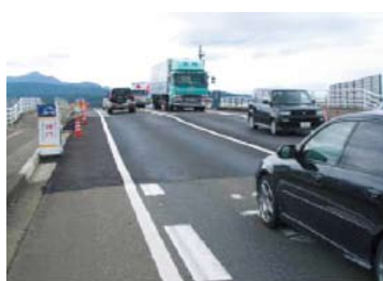
写真2-2-26 段差をすりつけ開放(比角跨線橋)
