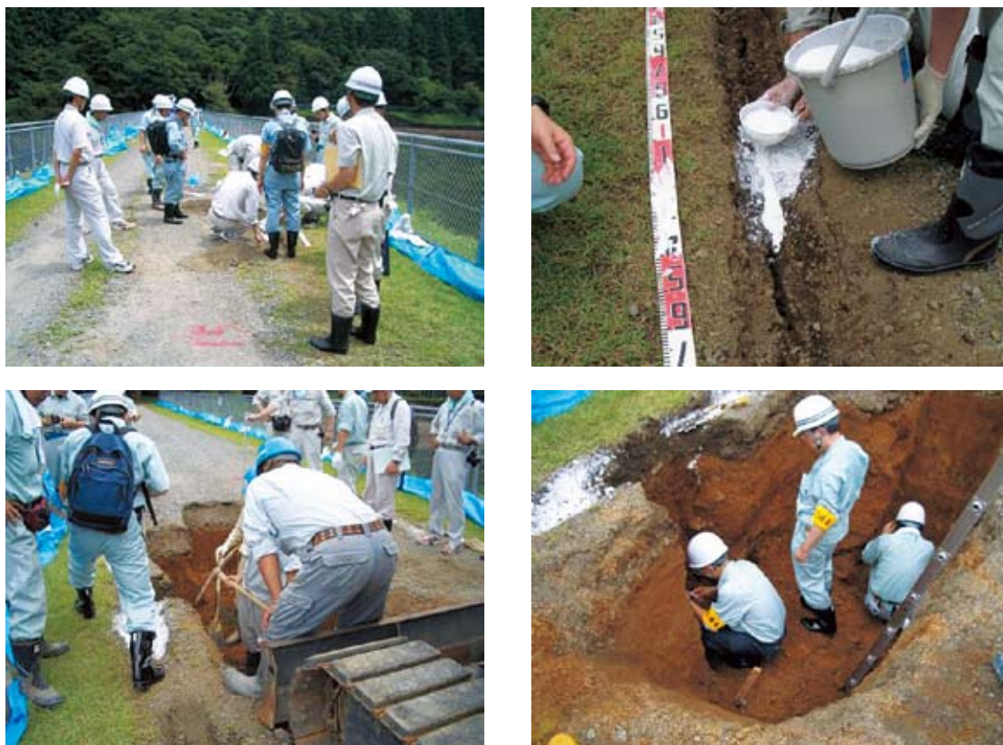
写真3-5-4 川内ダムトレンチ調査状況
