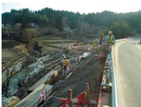
写真4-3-1 アンカー施工状況
