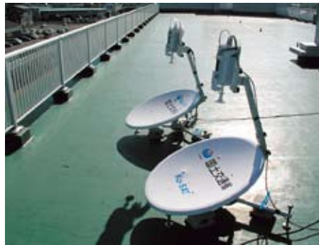
写真3-15-4 受信用Ku-SATの設置・運用状況(柏崎地域振興局)
