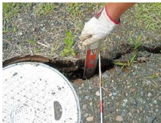
写真3-5-1 川内ダムの天端クラック状況
