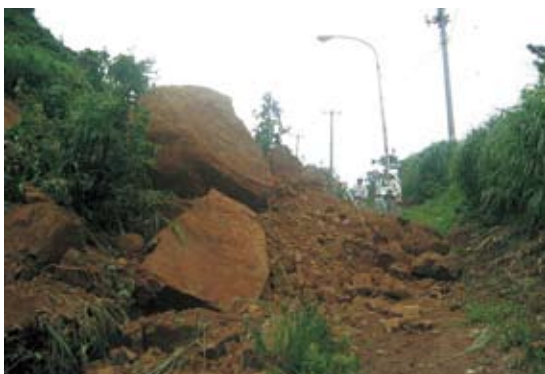
写真3-8-6 道路をふさいだ崩落土砂 (照明灯付近に調査を行う専門家の
