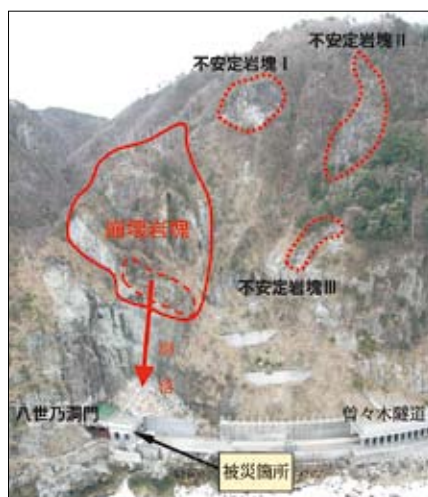
写真3-8-6 八世乃洞門被災状況その1
