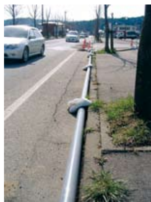
写真2-2-17 仮設配管による対応状況(輪島市走出地区)
