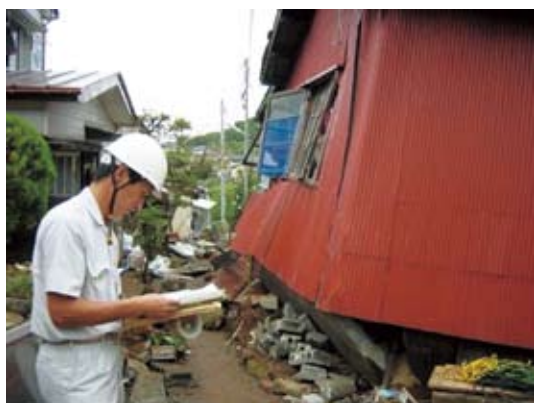
写真3-2-3 判定調査の状況
