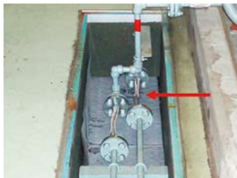
写真2-5-6 発動発電装置 本復旧が完了した発電機給油管の可とう部
