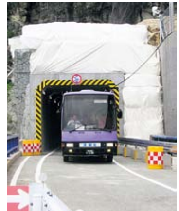
写真3-8-8 応急復旧が完了し通行する観光バス
