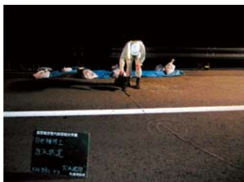
写真2-1-7 路面の亀裂への注入作業
