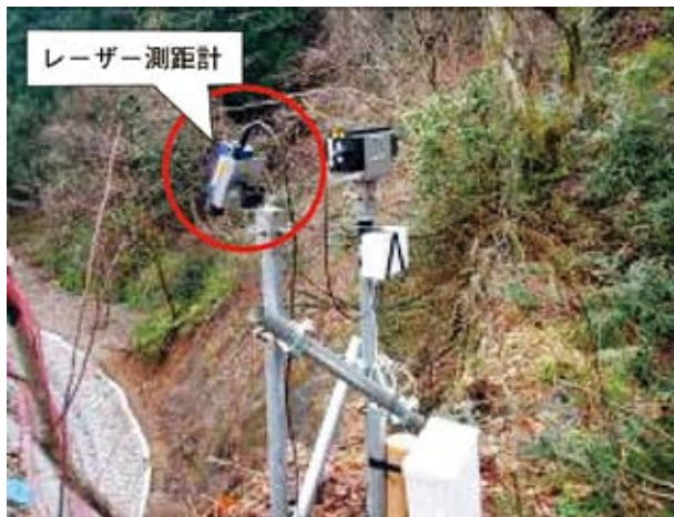
写真2-6 レーザー測距型斜面監視装置の設置状況
