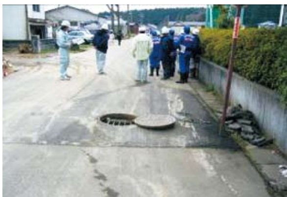
写真3-6-1 現地調査状況(穴水町大町)
