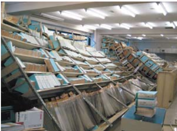
写真2-3-2 書庫内の状況
