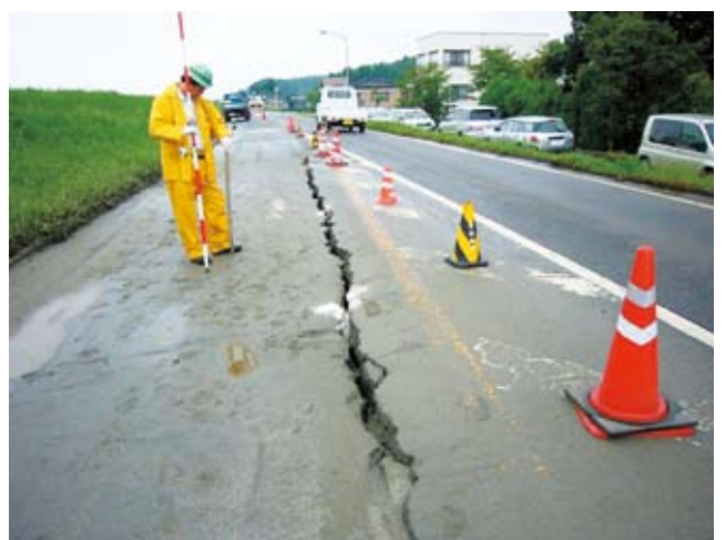
写真2-1-10 堤防亀裂
