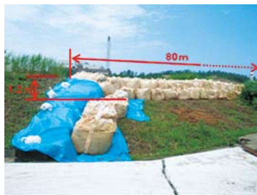
写真3-6-2 堤防沈下箇所に於ける応急復旧
