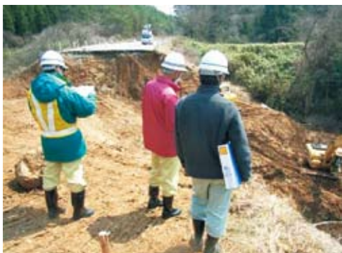
写真3-8-4 現地で被災状況を確認
