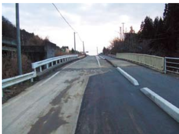
写真4-3-17 オフランプ部舗装打換完了
