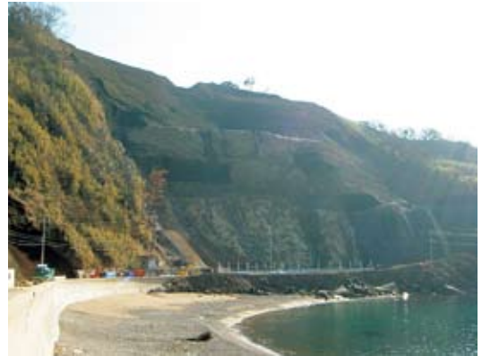
写真3-8-11 復旧後の山側斜面状況
