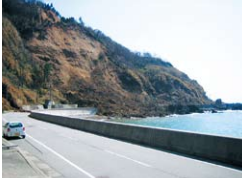
写真3-8-9 道下深見線(深見集落側)
