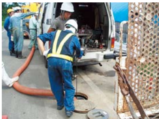
写真3-4-3 2次調査実施状況 （カメラ挿入の様子）
