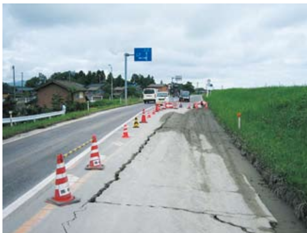
写真4-2-1 堤防の亀裂
