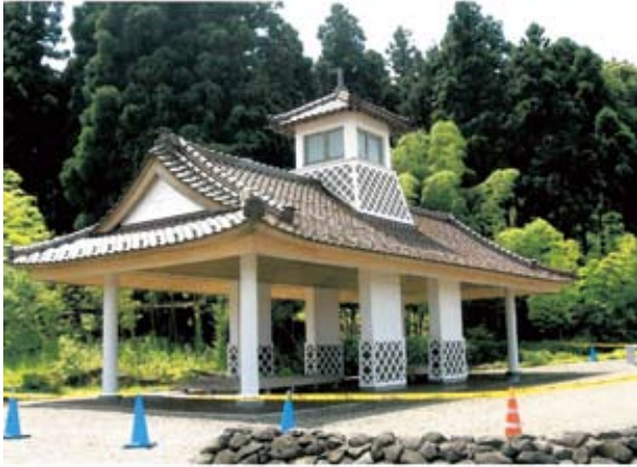
写真4-4-1 地の陣（復旧完了8.31）
