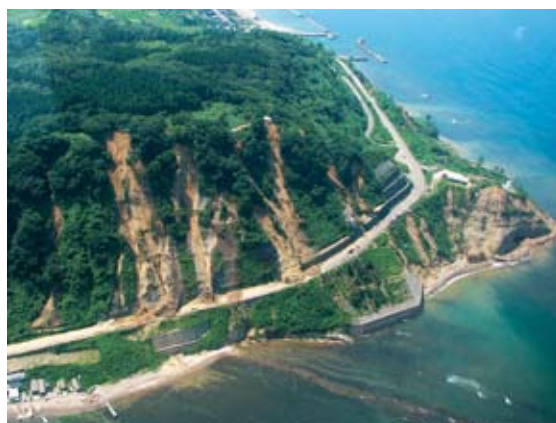
写真2-2-4 法面崩落(国道352号柏崎市椎谷)
