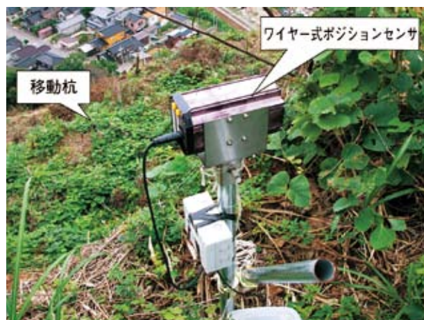
写真2-5 ロングスパン地表伸縮計の設置状況
