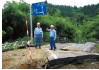
国道8号長岡市大積千本町の視察状況
