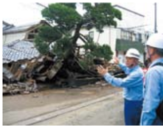
家屋被災状況を視察
