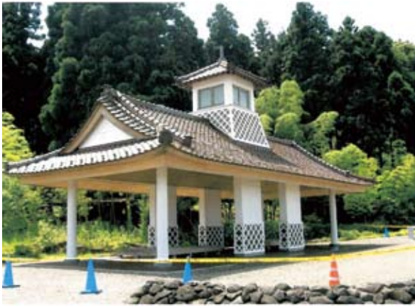
写真4-4-1 地の陣（復旧完了8.31）
