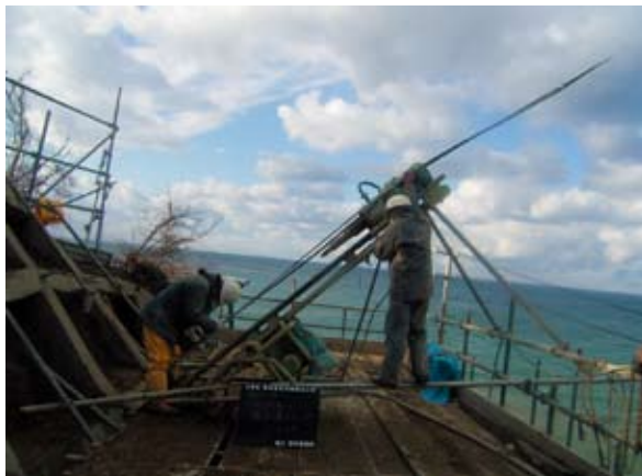
写真4-3-13 法枠のアンカー施工状況
