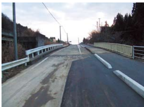
写真4-3-17 オフランプ部舗装打換完了
