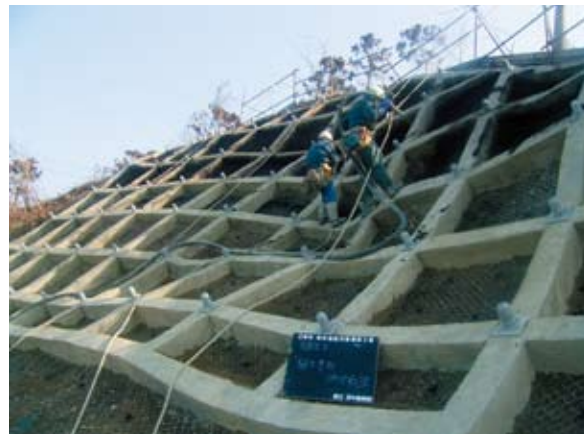
写真4-3-14 法面への植生基材吹き付け状況
