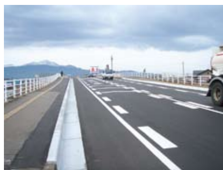
写真4-3-8 歩車道舗装完了
