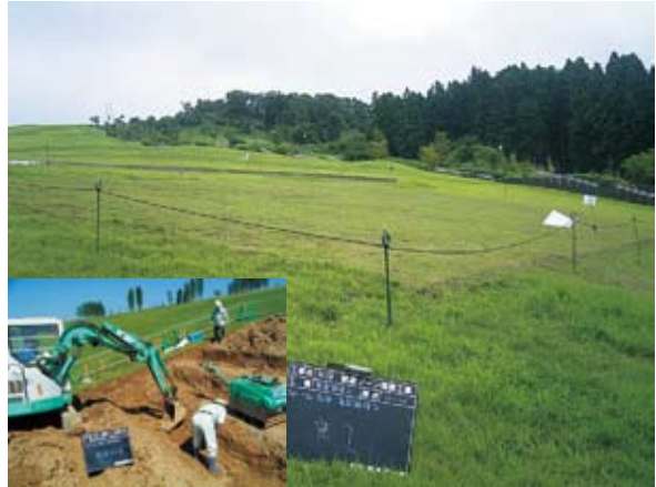
写真4-4-2 法面（補修完了9.4）
