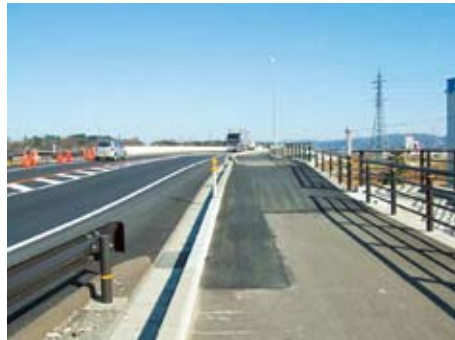
写真4-3-4 歩車道舗装打換完了
