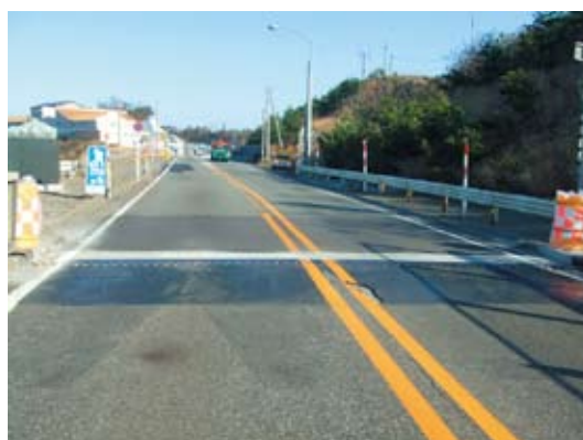
写真4-3-12 伸縮装置取替、舗装すりつけ完了
