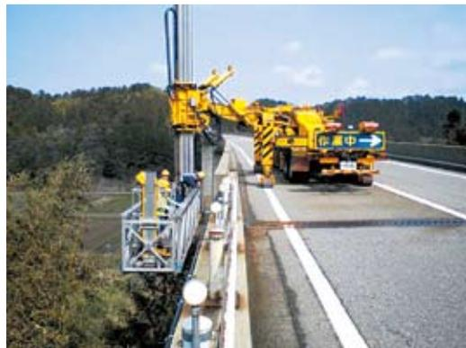
写真3-10-3 緊急橋梁点検(能登有料道路)
