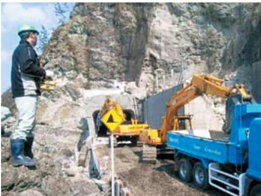
写真3-10-2 遠隔操縦式BH(八世乃洞門)
