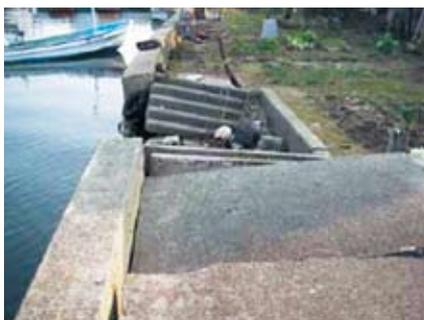
写真 3-9-6 穴水港(乙ヶ崎地区)海岸護岸破壊状況
