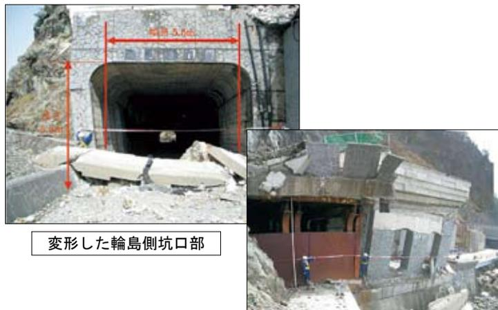
写真3-8-7 八世乃洞門被災状況その2
