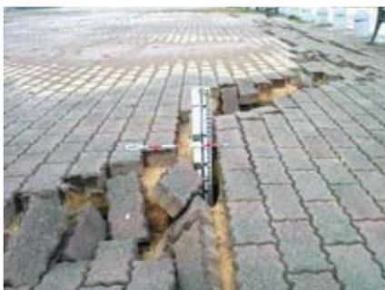
写真 3-9-5 和倉港野積場沈下状況
