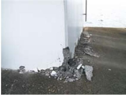
写真3-5-2 P6橋脚の被災状況その1
