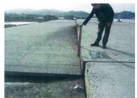
写真 3-9-7 輪島港(河合地区)岸壁(水深7.5m)エブロン沈下状況
