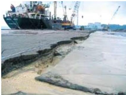
写真 3-9-1 七尾港(大田地区)野積場沈下状況
