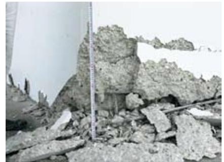
写真3-5-4 P7橋脚の被災状況その1
