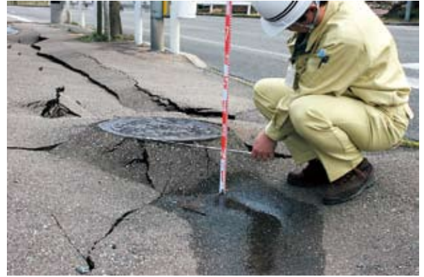
写真2-2-15 マンホール周辺の変状(輪島市本市地区)
