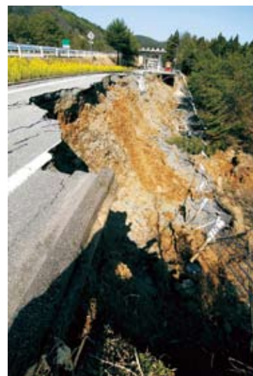
写真2-1-2 能登有料道路 横田IC 道路崩壊
