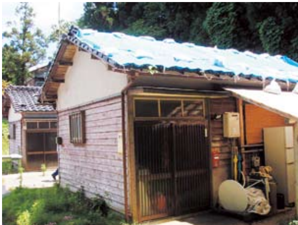
写真2-2-20 輪島市営館住宅(公営) (屋根損傷の応急復旧)
