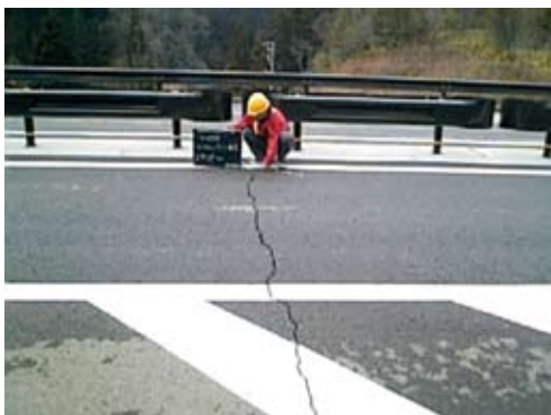
写真2-1-1 国道470号穴水道路 路面亀裂
