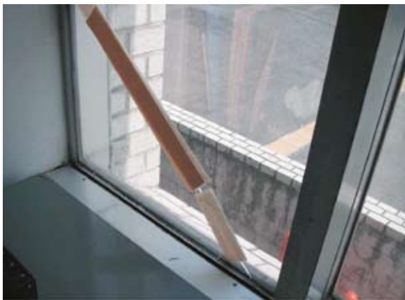
写真2-3-3 窓ガラスのひび割れ
