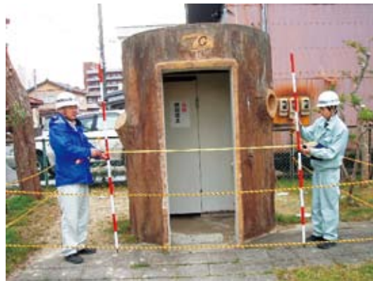
写真2-2-7 桜ヶ丘児童公園の応急対応(トイレ使用禁止のためのロープ設置)
