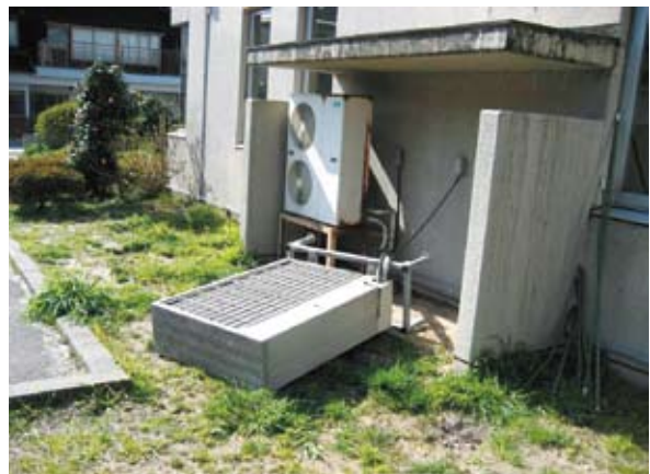
写真2-3-4 室外機の転倒
