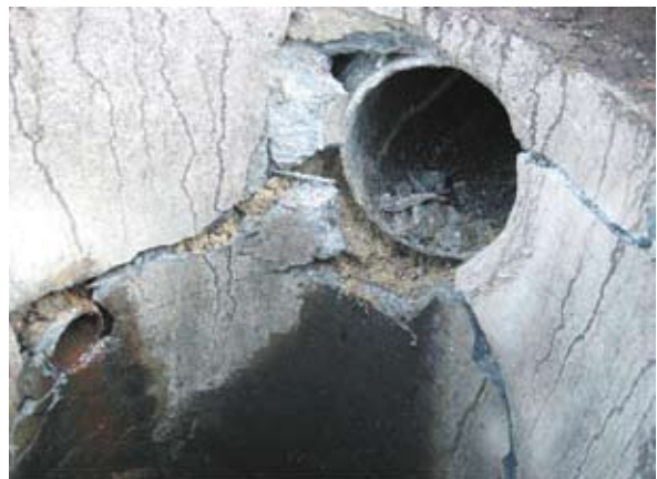
写真2-3-6 排水樹の破損
