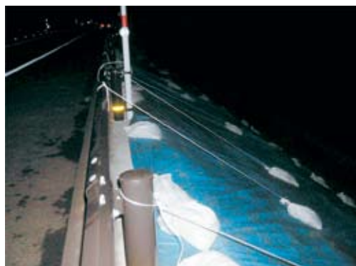
写真2-1-8 シート張り施工状況
