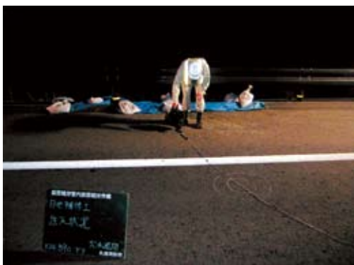
写真2-1-7 路面の亀裂への注入作業
