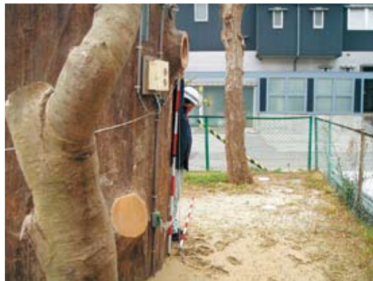
写真2-2-4 桜町児童公園の被災状況 (トイレ付近の液状化)
