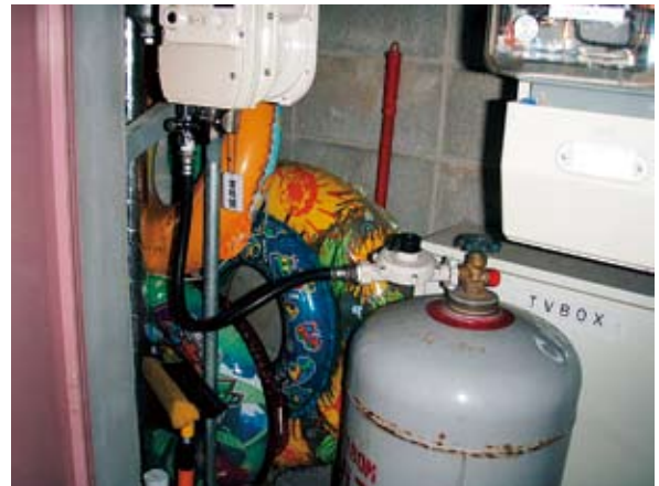
写真2-2-21 輪島市営さくら住宅(特公賃) (設用プロパンガスボンベ設置)
