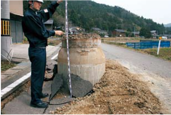
写真2-2-14 マンホールの隆起(輪島市田村地区)
