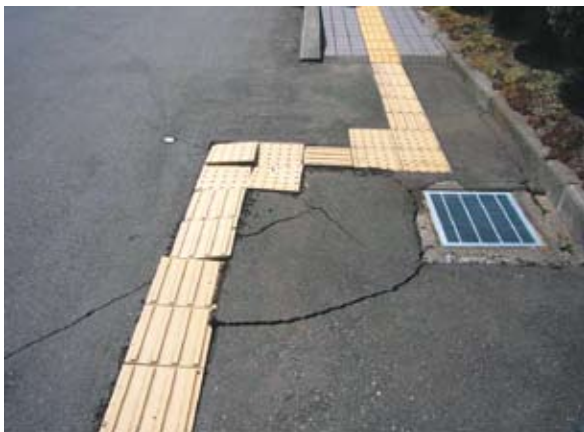
写真2-3-5 舗装のひび割れ
