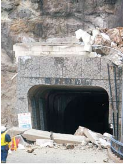
写真2-1-3 国道249号八世乃洞門 岩盤崩落
