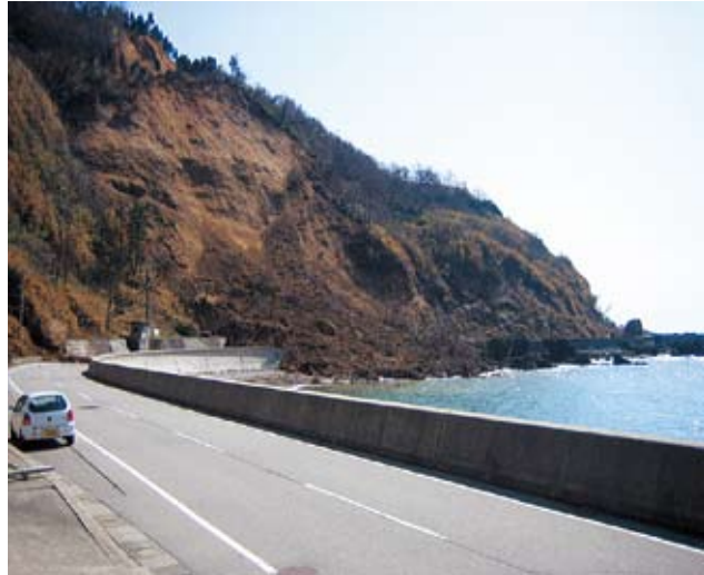
写真2-1-4 輪島市道 道下深見線 法面崩落
