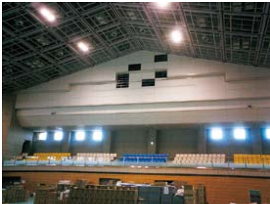
写真2-2-1 一本松総合運動公園の被災状況 (体育館内装材の剥落)
