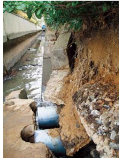
写真2-2-2 白崎公園の被災状況 (土留め用壁転倒)
