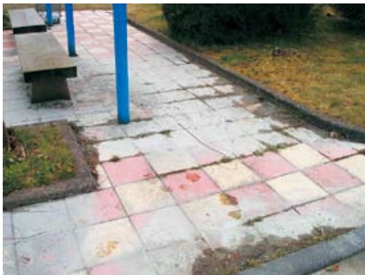
写真2-2-3 つつじが浜児童公園の被災状況 (平板ブロック変状)
