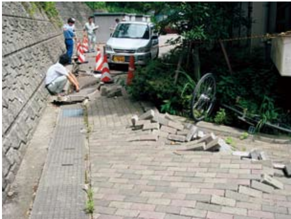
写真2-2-18 輪島市営さくら住宅(特公賃) (インターロッキングブロック舗装の被害)
