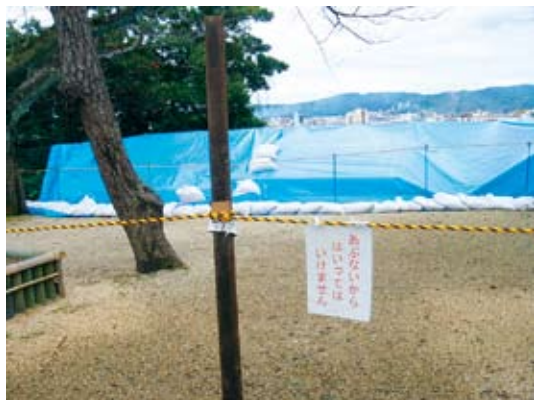
写真2-2-8 小丸山公園の応急対応(浸水防止ブルーシート、ロープ設置)
