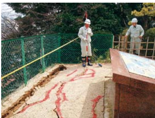
写真2-2-5 小丸山公園の被災状況(土留擁壁のずれ)
