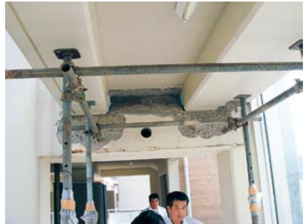
写真2-2-19 輪島市営広岡住宅(公営) (渡り下の被害)
