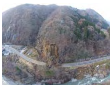
国道148号の土砂崩落状況把握 (UAVで撮影)
