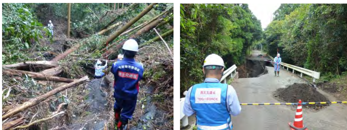
図-25 台風 26 号災害（伊豆大島）における TEC-FORCE による現地被災調査
