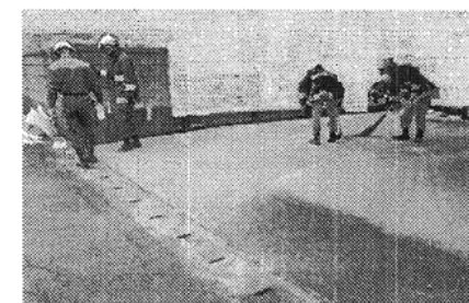
吸着材などを使って、もれた油を取り除く作業
