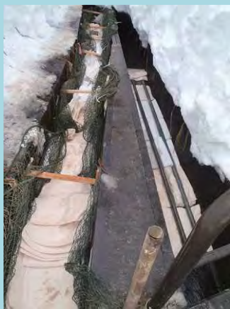
【水路に設置した吸着マット】
