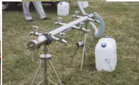
飲料水の確保 (阿賀野市上下水道局)
