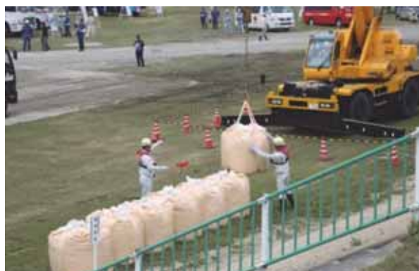
大型土のう工（新潟県）
