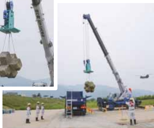
ブロック投入工（国土交通省）
