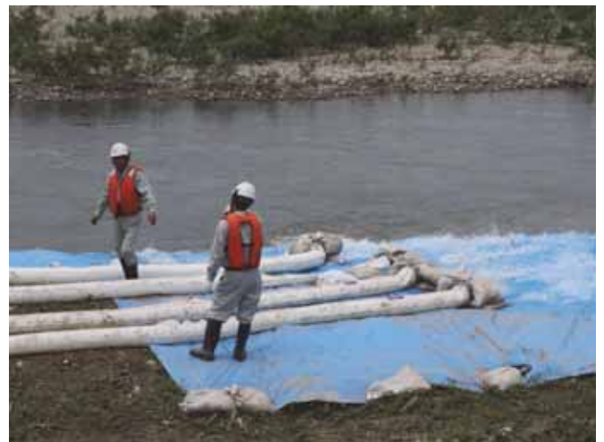
ポンプ稼働状況
