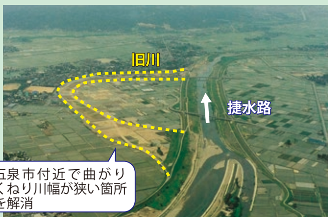
完成直後の捷水路
