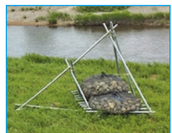
しん かわくら ようしき すいせい こうせい かわくらこう 新川倉様式水制（鋼製川倉工） 川倉工は、堤防の洗掘拡大を防ぐ伝統工法です。新川倉様式水制は材料の丸太を現代に合わせ、単管としたものです。
