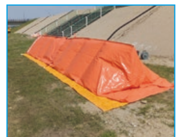
さんかく すい こう 三角水のう工 土のうに比べ、軽量で設置も早く簡単、水を注入して越水を防ぐ新発想の可搬式特殊堤防工法
