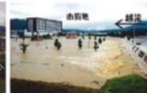
藍川の氾濫状況 （愛知県大治町）
