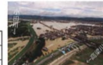
小田川の氾濫状況 （岡山県倉敷市真備町）
