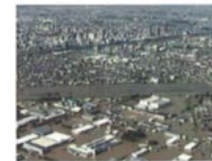
阿武隈川の氾濫状況 （福島県郡山市）
