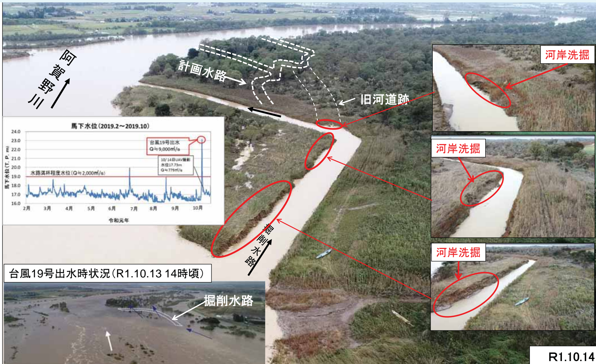
水ヶ曾根地区 台風19号出水後
