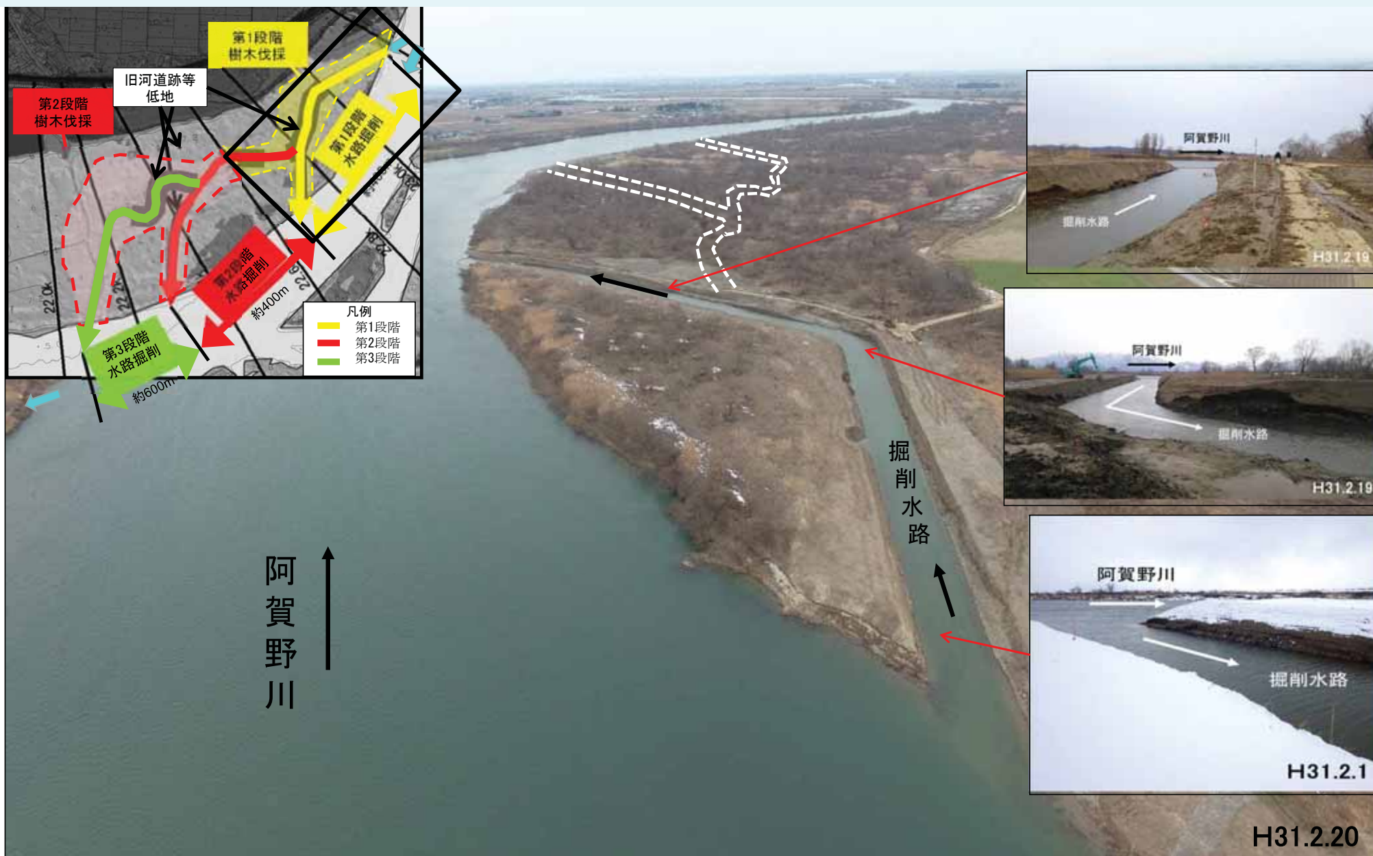
水ヶ曾根地区 工事直後
