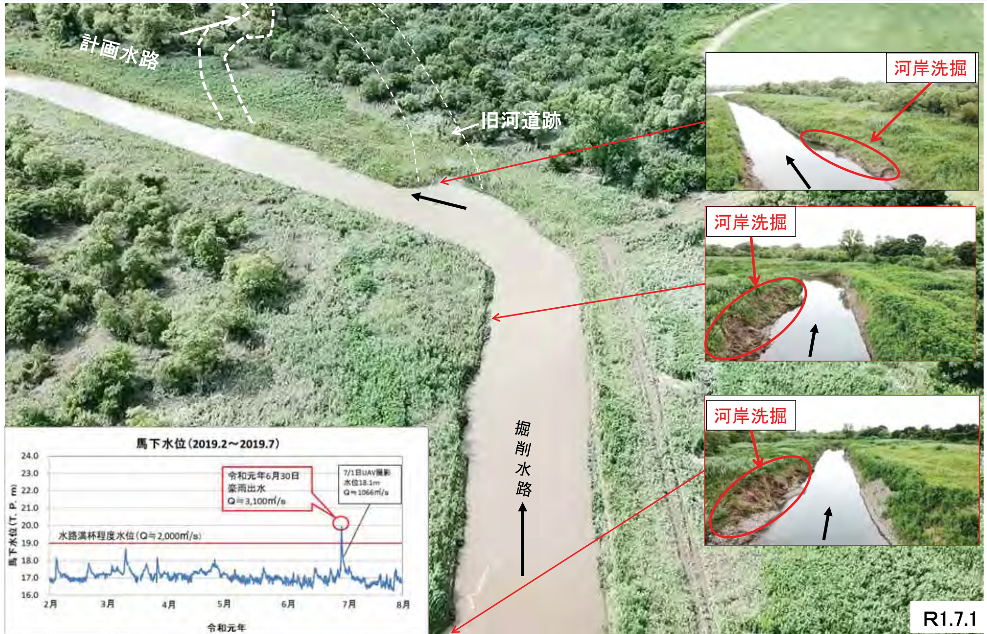
水ヶ曽根地区 6月30日豪雨出水後
