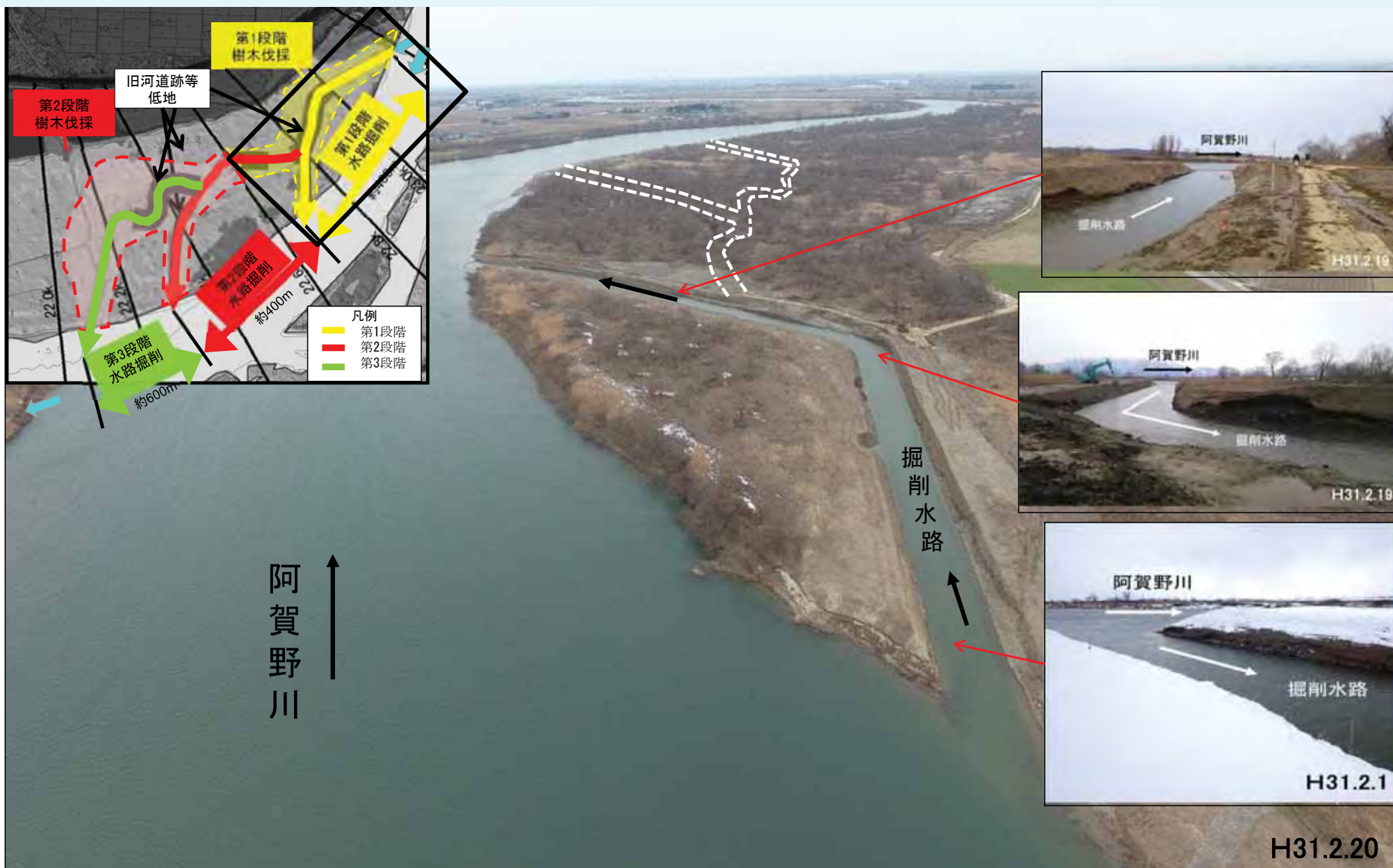
水ヶ曾根地区 工事直後
