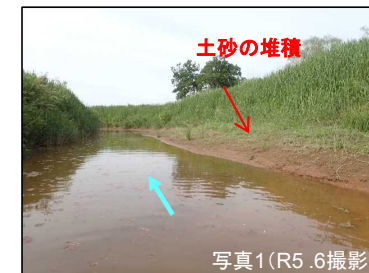
出水後水路状況
