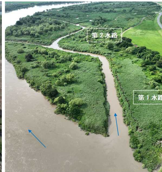
令和5年6月29日 出水時 （第1、第2水路）
