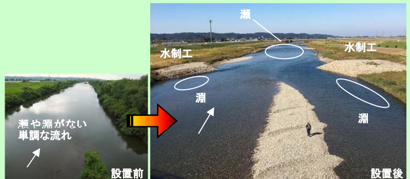
図-2 早出川における拡縮流路施工前後の状況
