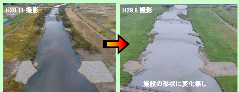
図-12 出水前後の施設状況(H29.7出水:観測史上第4位)
