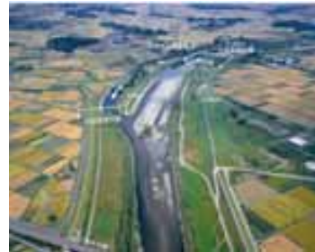
三本木大橋～善願橋付近
