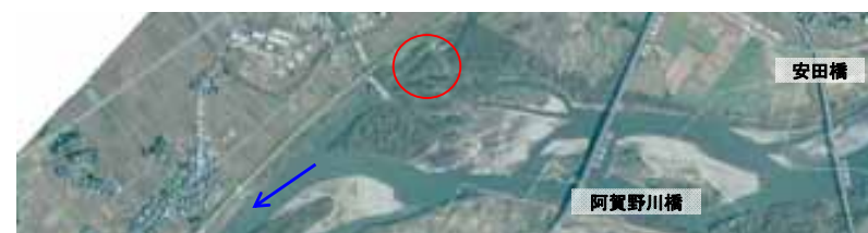
図 4.5-3 対策の実施箇所（小浮地区：26.6～26.8k 右岸）
