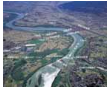
沢海床固工付近
