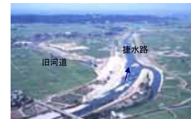
図 4.6-2 早出川捷水路と旧河道
