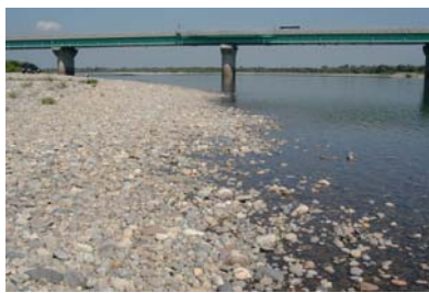
阿賀野川 27.5k 左岸より上流 (H14 河川調査)
