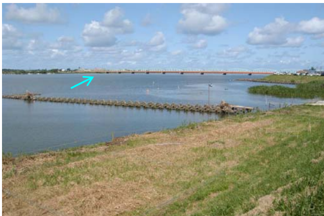
下流部の水制工
