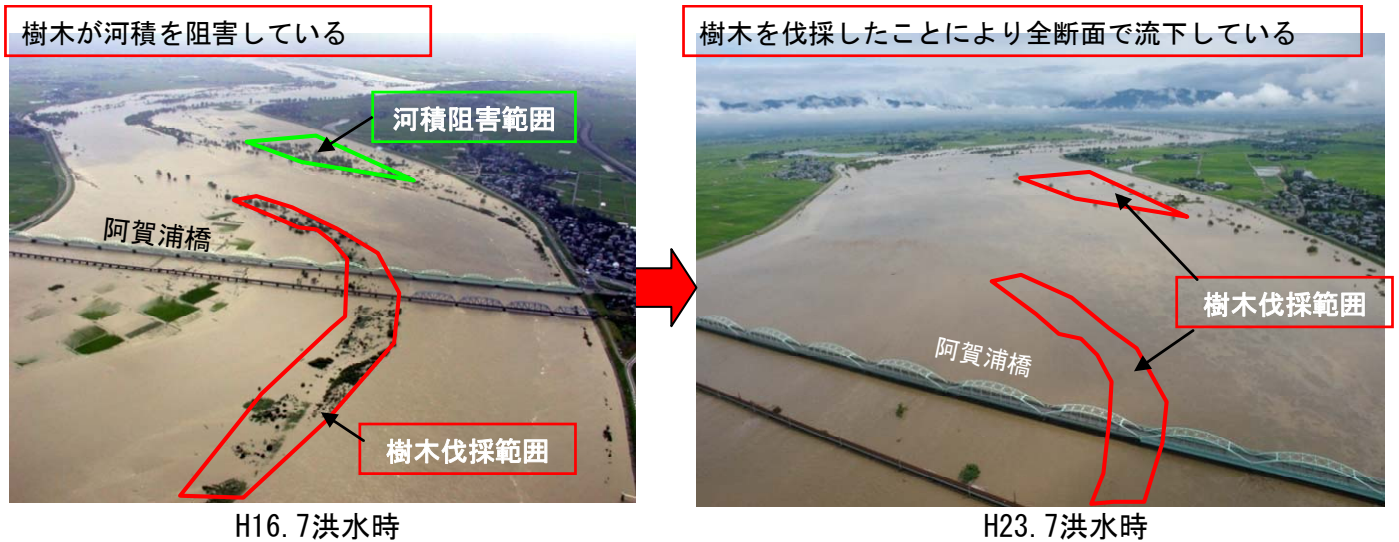
写真 中新田地区の樹木伐採の前後の状況 (洪水時)
