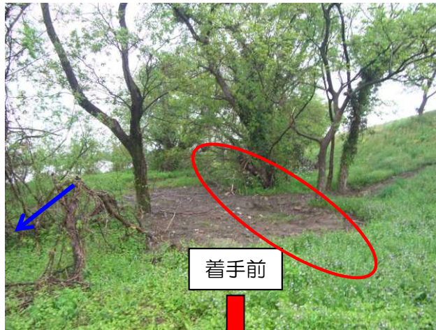
小松護岸及び渡場堤防漏水災害復旧工事 渡場工区【堤防基盤漏水 L=100m】 （阿賀野市渡場地先、左岸29.6k付近）
