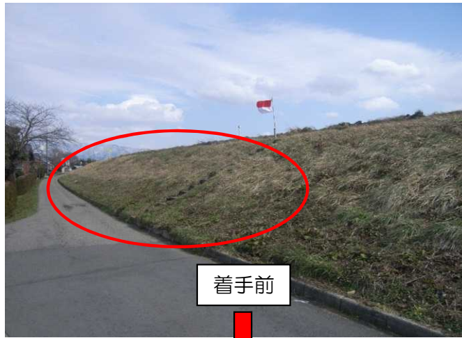
法柳及び嘉瀬島堤防漏水災害復旧工事 嘉瀬島工区【堤防漏水・法崩れ L=120m】 （阿賀野市嘉瀬島地先、右岸20.4k付近）
