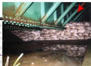
JR羽越線橋梁取付部対策
